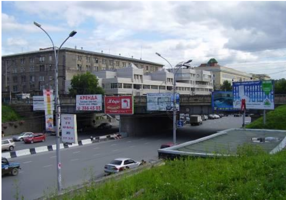
Красный проспект. Путепровод. 2010г.
