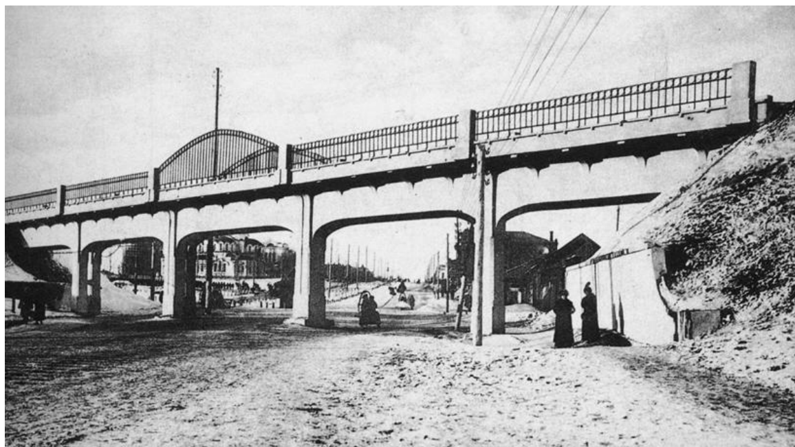
Путепровод Алтайской ж\д над Красным проспектом.
