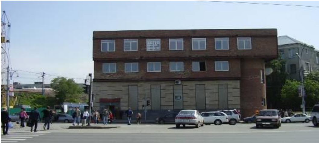
Строящееся здание Автовокзала. 2008г.
