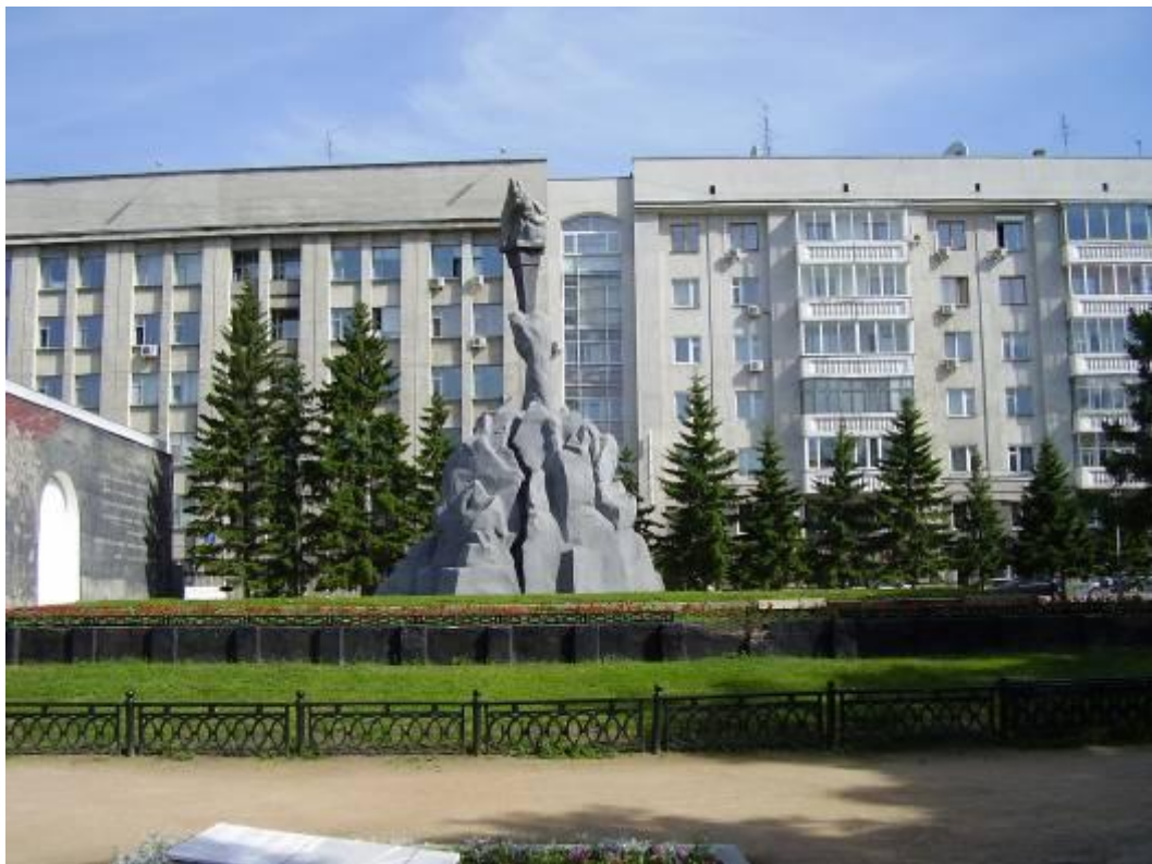
Крыло здания Мэрии и жилой дом по ул. Щетинкина. 2008г.
