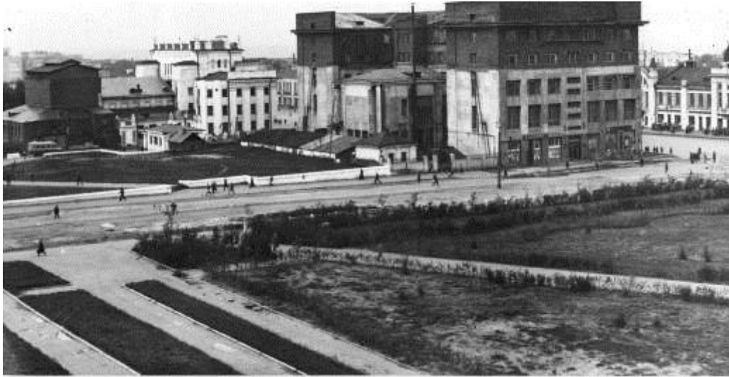
Между трамвайной остановкой и зданием Горисполкома.
