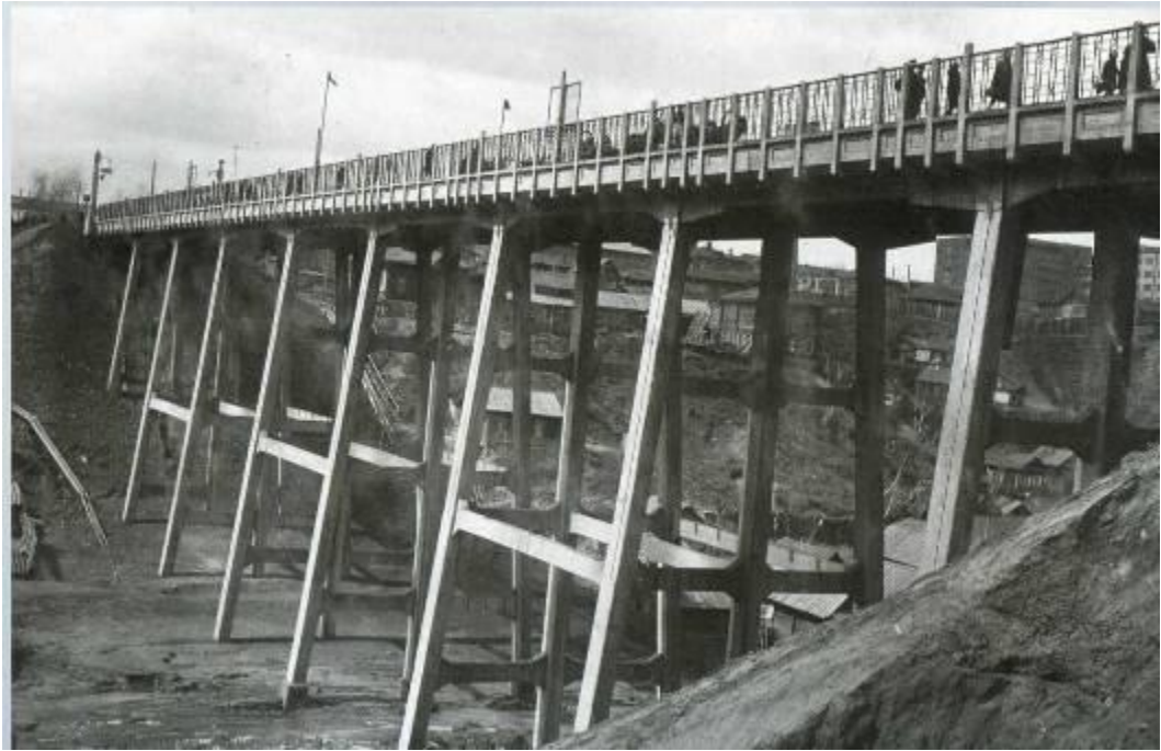
«Бетонный мост». Построен в 1926г. Автор М.А. Ульяновский. Вид со стороны Октябрьского района.
