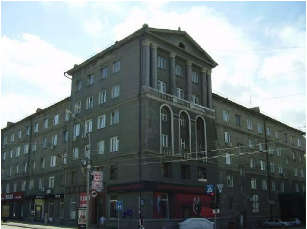
Красный проспект №71 (со стороны ул. Достоевского). 2008г.
