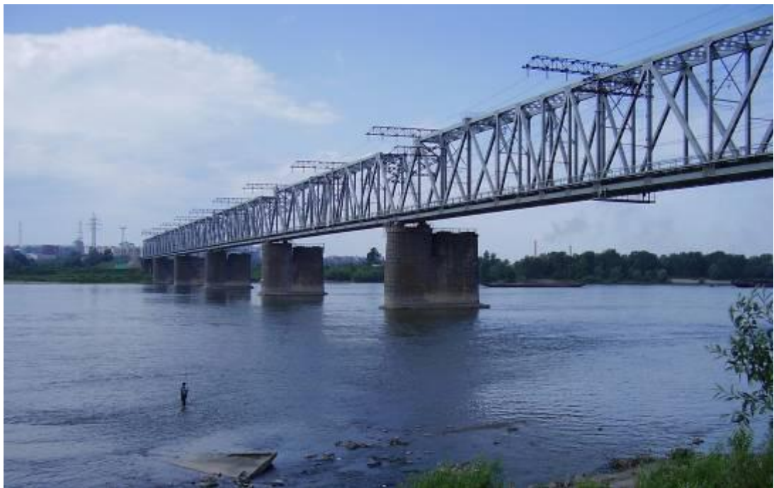
Железнодорожный мост через р. Обь. Новая колея на первоначальных опорах. 2008г. Слева внизу на фото виден поток р. Каменка.
