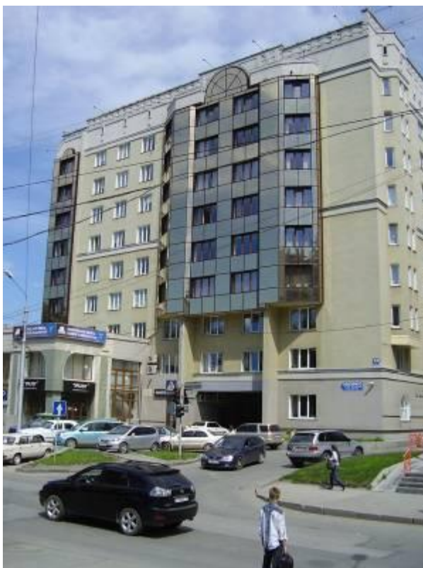
Здание, перегородившее ул. Депутатскую. 2008г.
