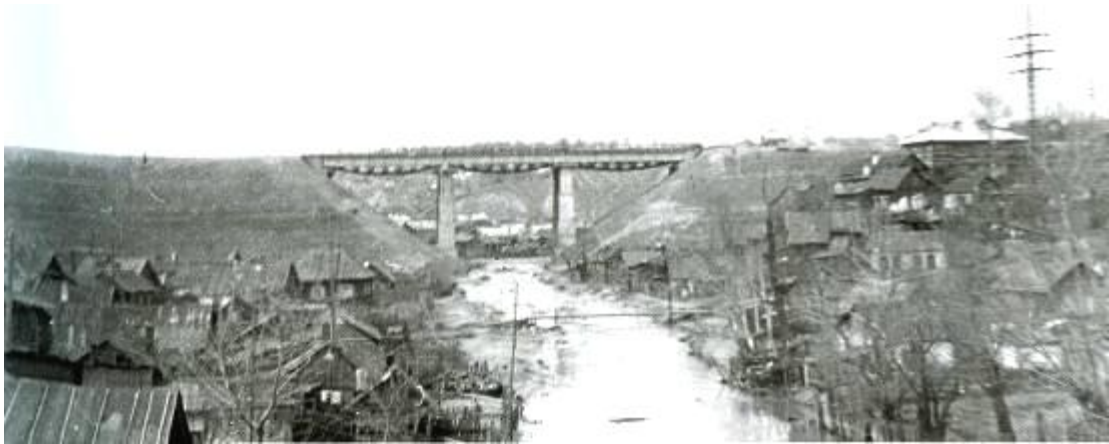
ЖД мост через р. Каменка. Застройка поймы р. Каменка. Вид с автодорожного моста.
