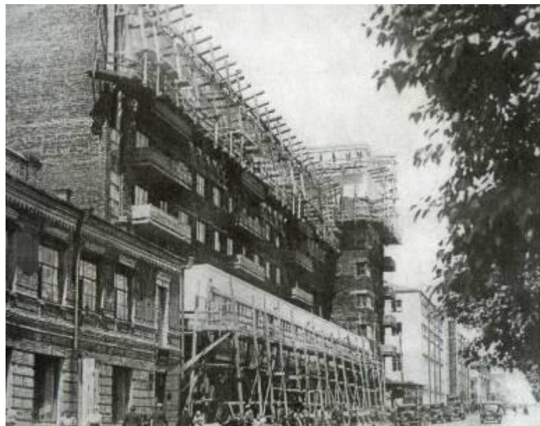
Строительство «Дома под часами».
