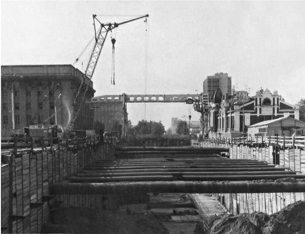
Площадь Ленина. Строительство метрополитена.
