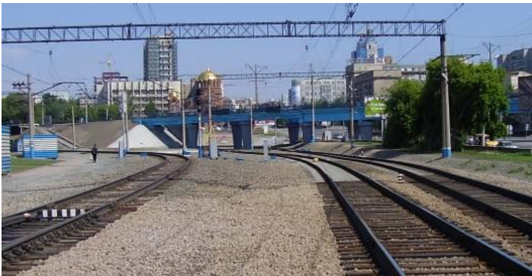
Путепровод над Транссибом. 2008г.
