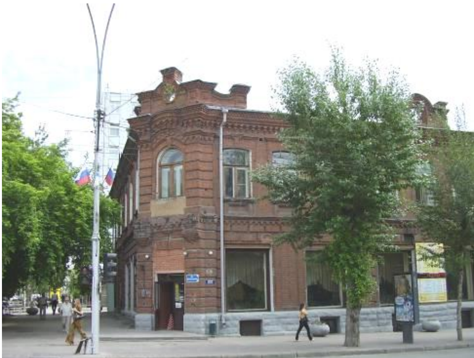
Старинное здание на углу Красного проспекта и ул. Октябрьской. 2008г.
