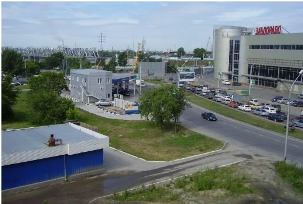
Выход Каменской магистрали к Южной площади. 2008г.
