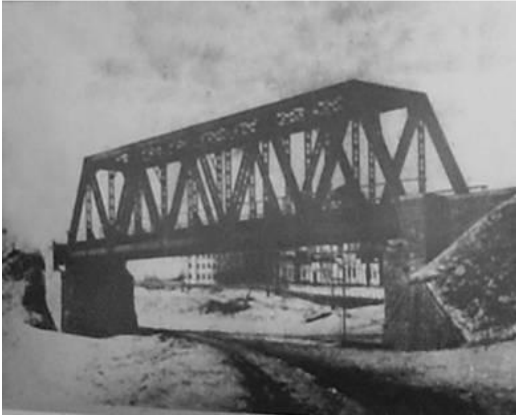
Мост Алтайской ж.д. Ферма над Транссибом.
