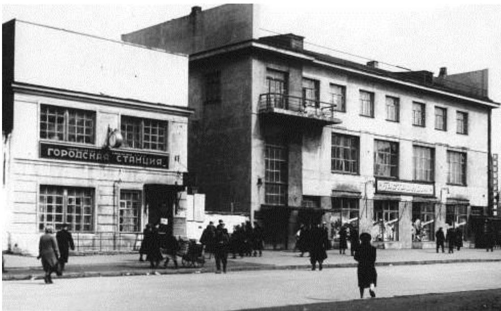
Ул. Орджоникидзе №29 на углу ул. Мичурина.
