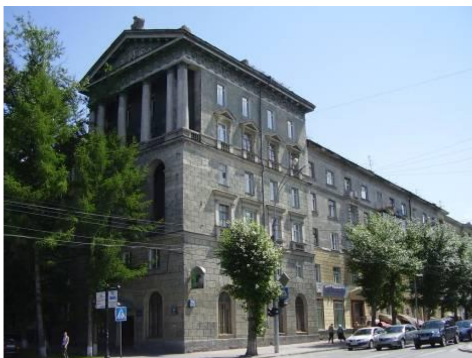
Угол Красного проспекта и ул. Достоевского. 2008г.
