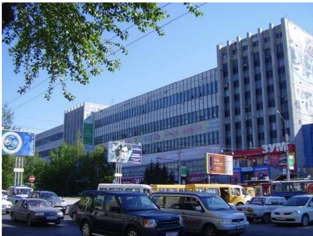
Красный проспект. Корпуса Приборного завода. 2010г.
