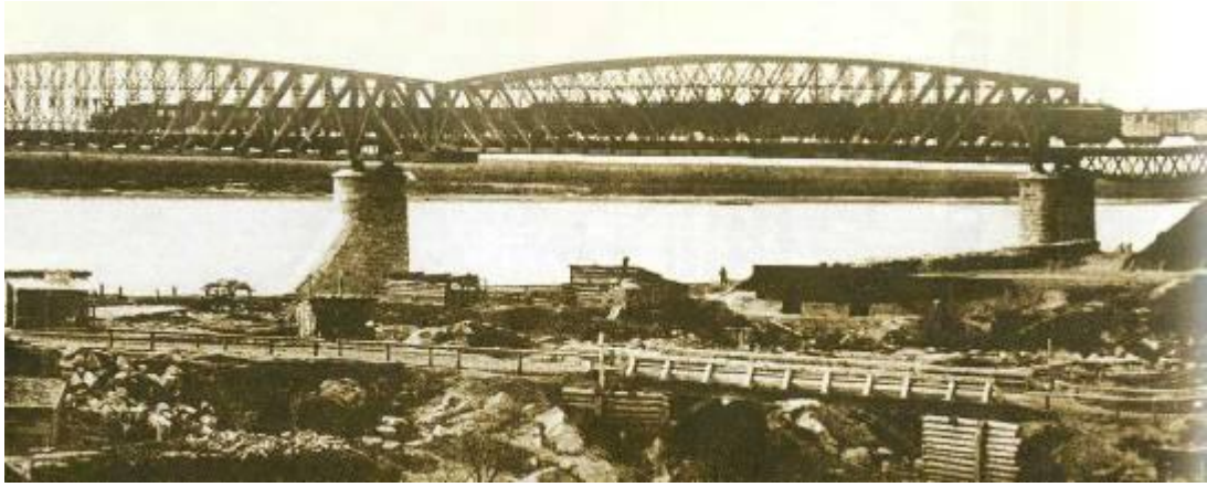
Железнодорожный мост через р. Обь.
