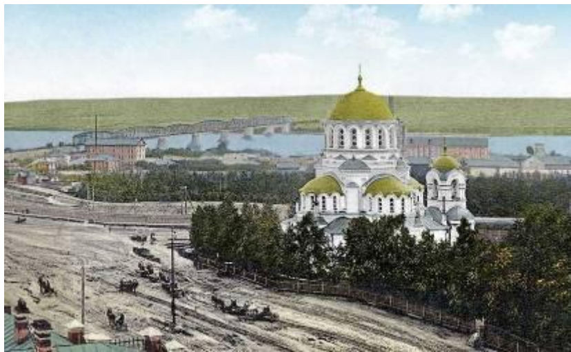
Вид на ж\д мост от Собора Александра Невского.
