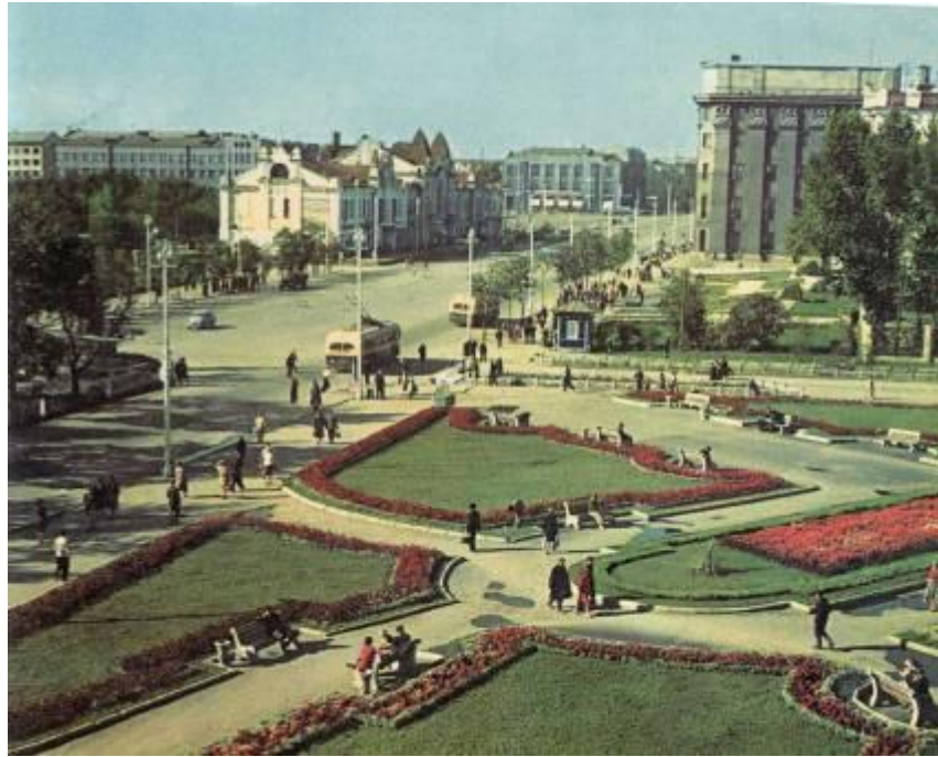
Площадь перед «Домом под строккой». 1965г.
