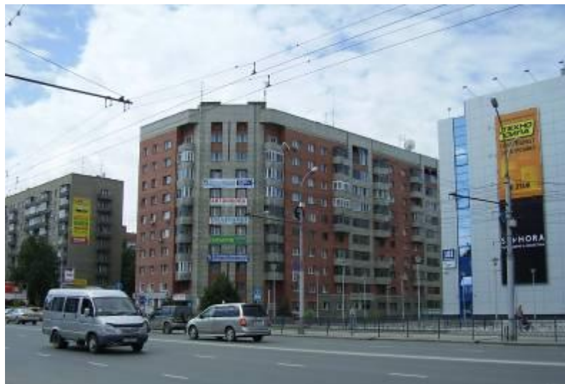
Красный проспект. Жилой дом. 2008г.
