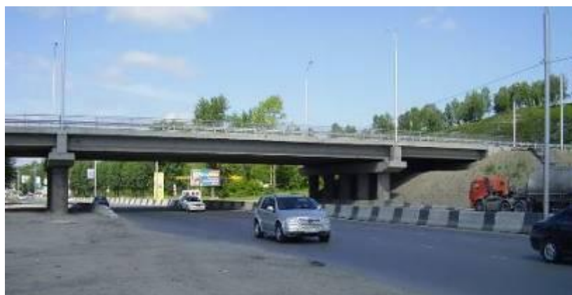
Путепровод на Бердском шоссе. 2009г.
