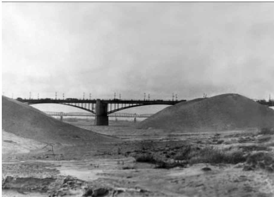
Подготовка нового пляжа перед Речным вокзалом.
