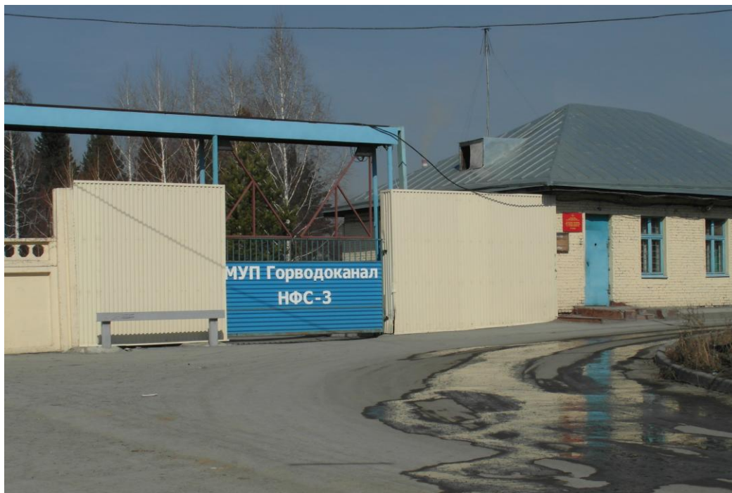
Насосно-фильтровальная станция. 2012г.
