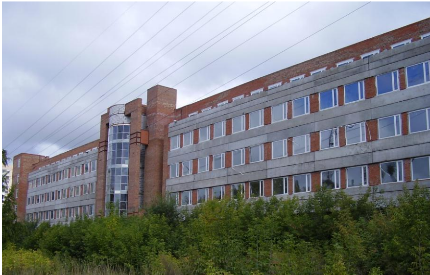
Ул. Б. Богаткова. Строящееся здание. 2008г.
