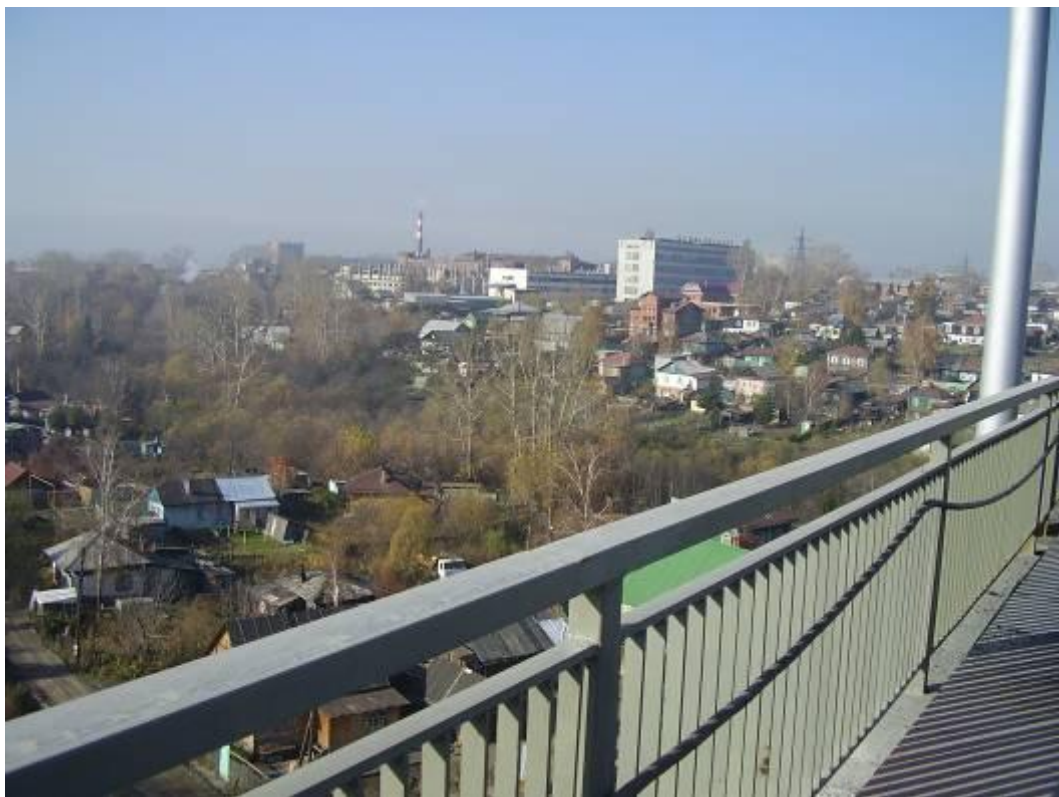
Застройка рядом с новой эстакадой. 2009г.
