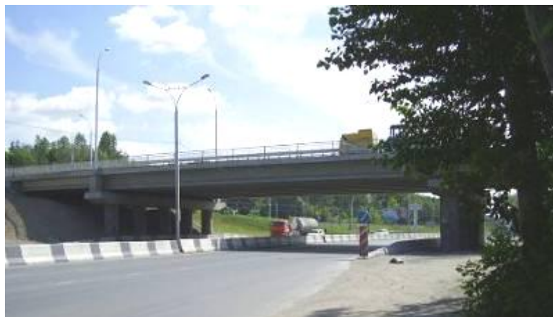
Путепровод на Бердском шоссе. 2009г.
