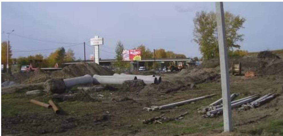
Строительство транспортной развязки. 2008г.
