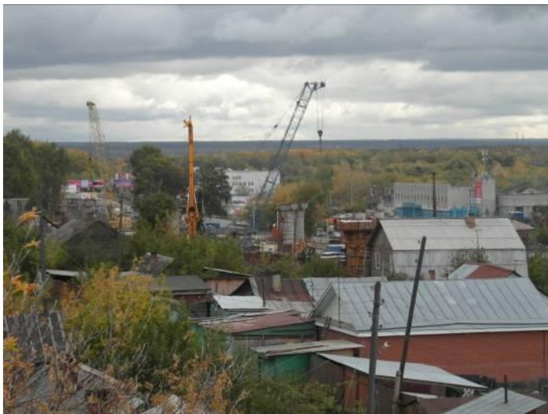
Вид с путепровода. Возведение опор будущей развязки на ул. Большевистской. 2012г.
