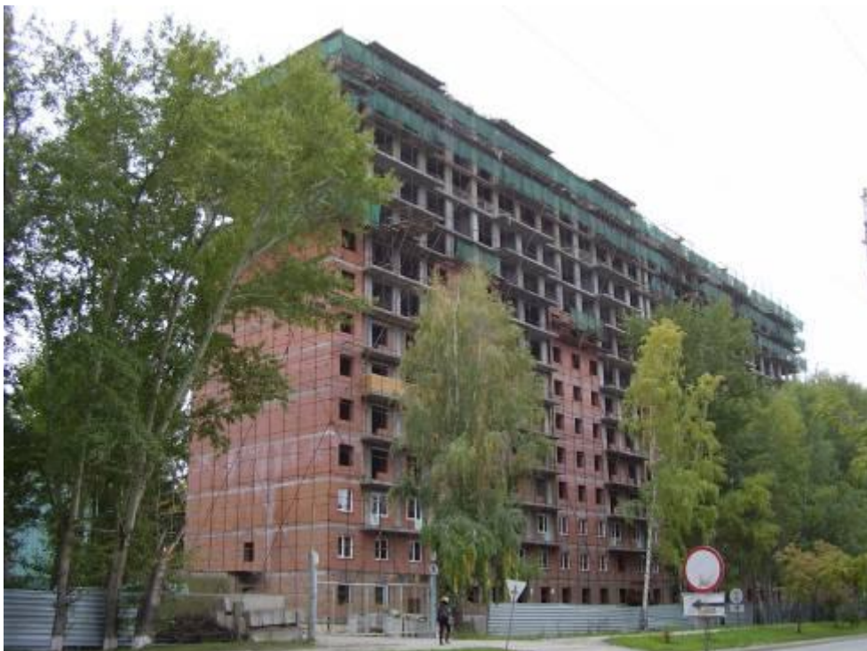
Ул. Добролюбова. Четная сторона. Строящееся здание. 2008г.
