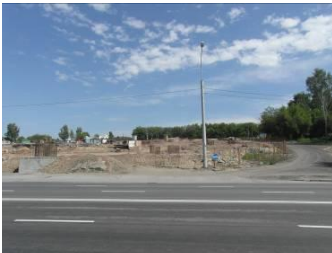
Ул. Большевистская. Сооружение транспортной развязки. 2012г.
