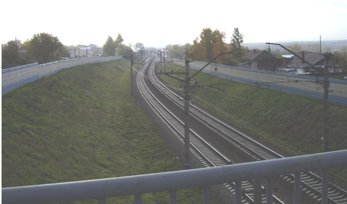
Вид с путепровода. 2008г.
