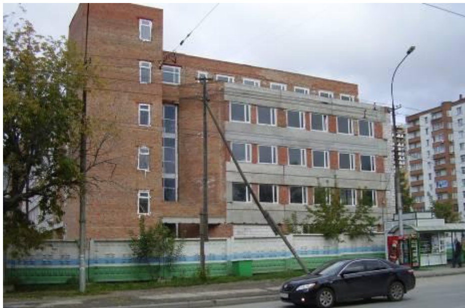
Ул. Б. Богаткова. Строящееся здание. 2008г.
