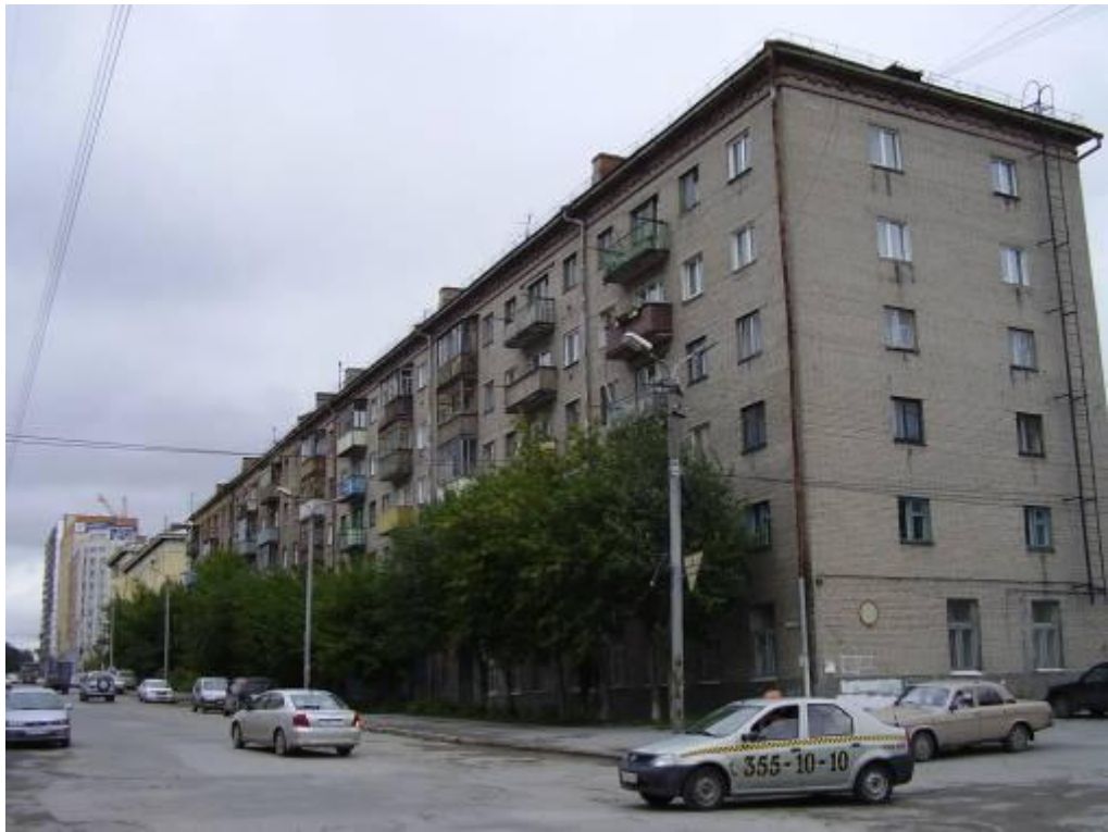
Ул. Сакко и Ванцетти. Нечетная сторона. Жилой дом. 2008г.
