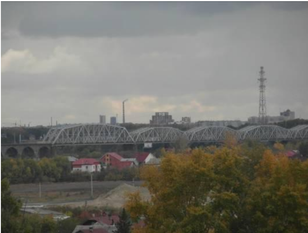
Вид с путепровода. Железнодорожный мост. 2012г.
