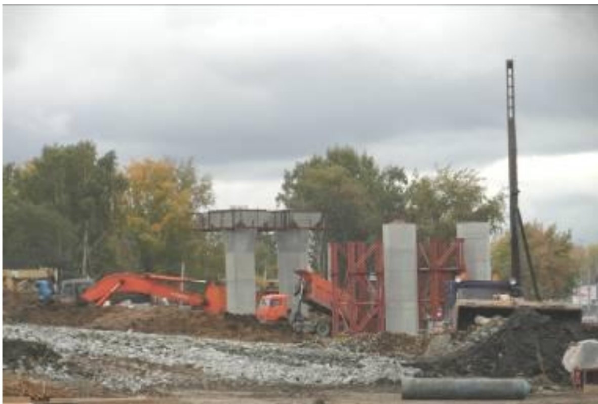
Ул. Большевистская. Сооружение транспортной развязки. 2012г.
