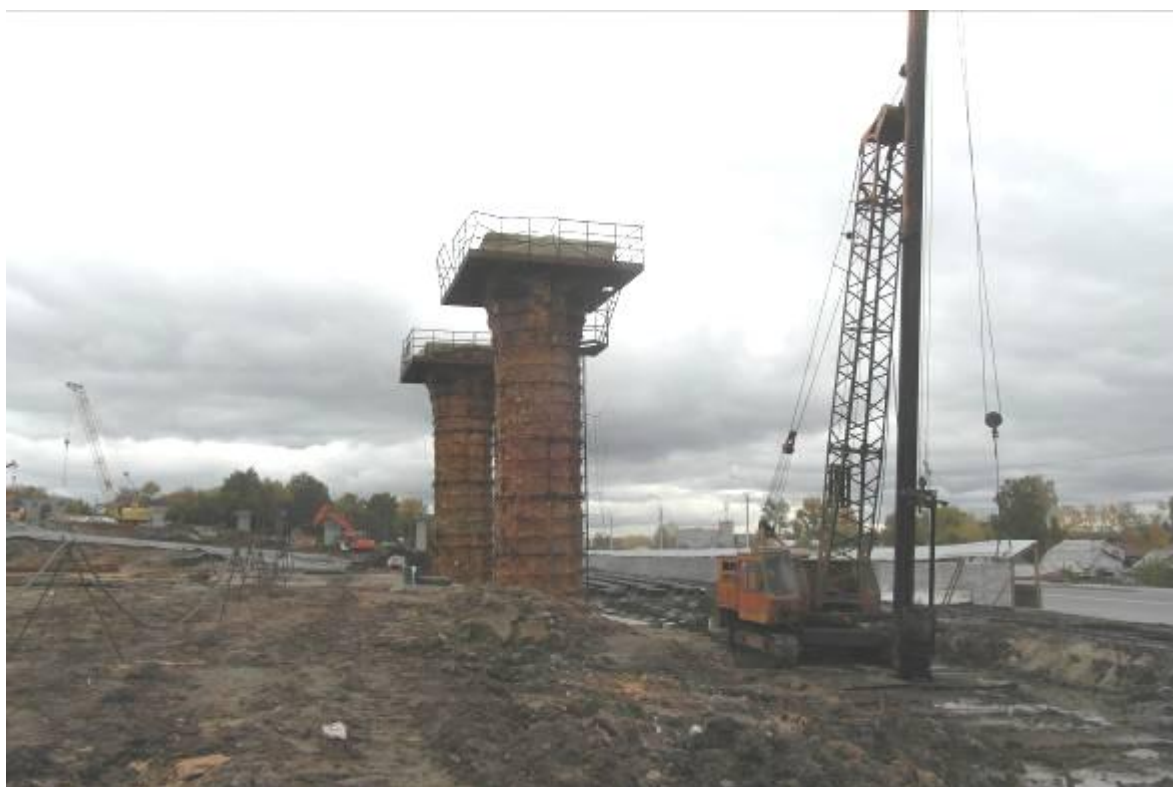
Ул. Большевистская. Сооружение транспортной развязки. 2012г.
