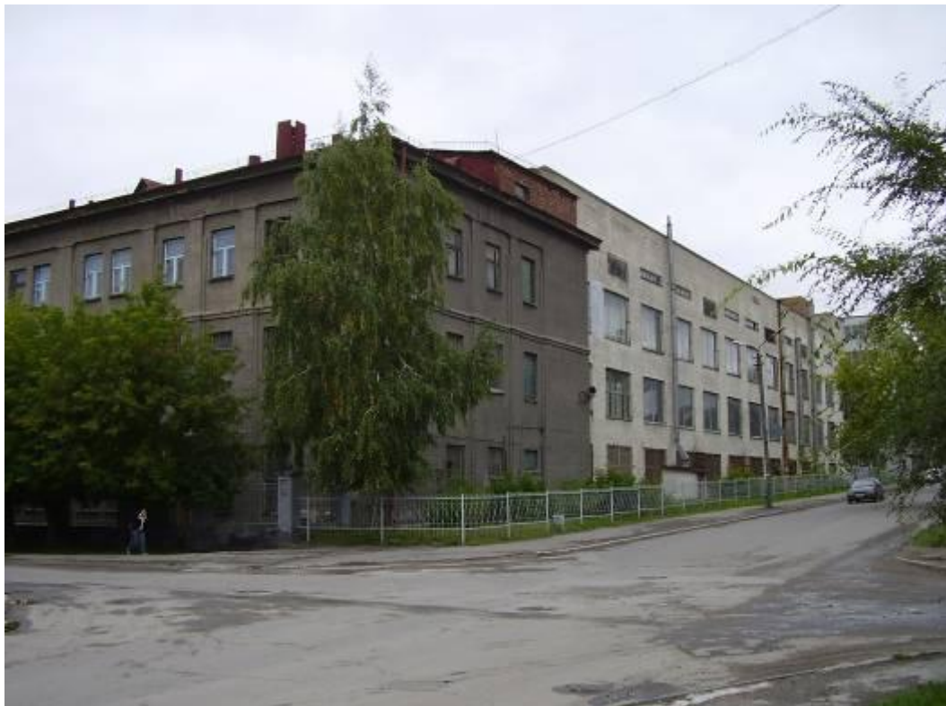
Угол улиц Б. Богаткова и Нижегородской. 2008г. Производственные корпуса.
