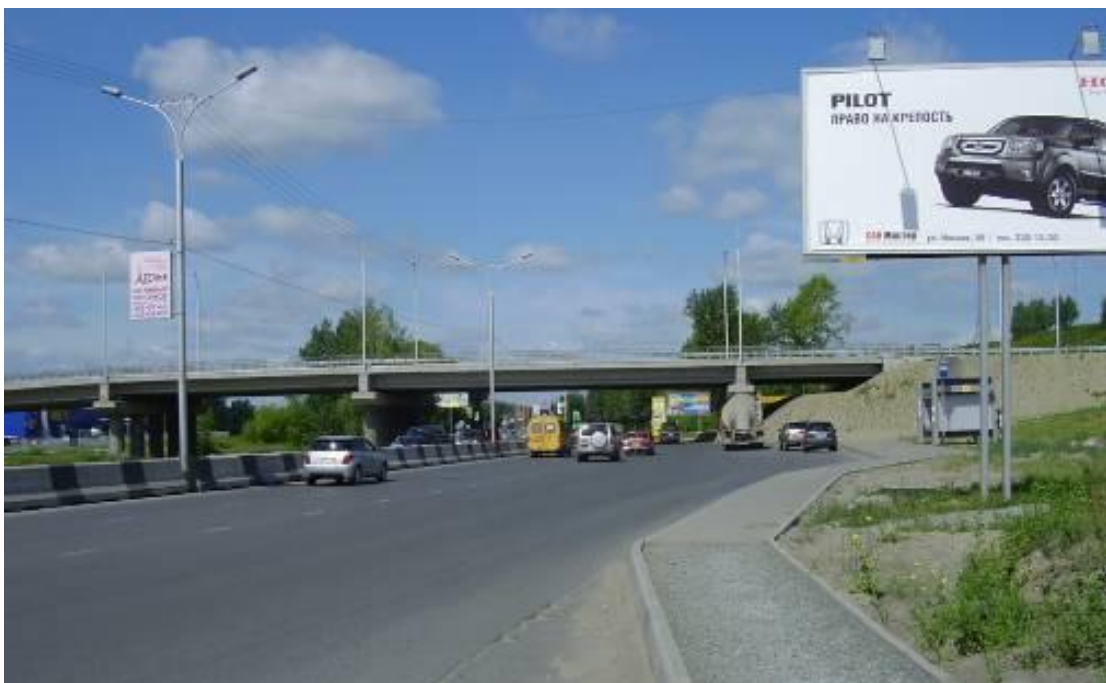
Путепровод на Бердском шоссе. 2009г.
