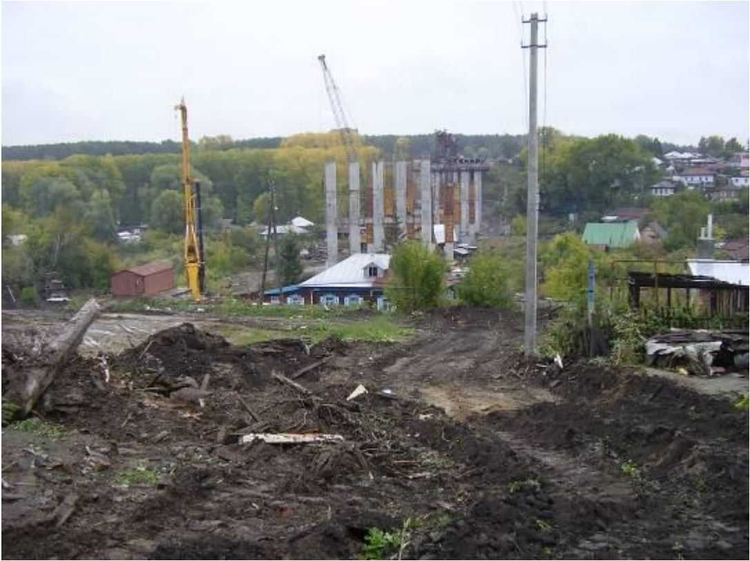
Строительство эстакады через овраг р. Плющихи. 2008г.
