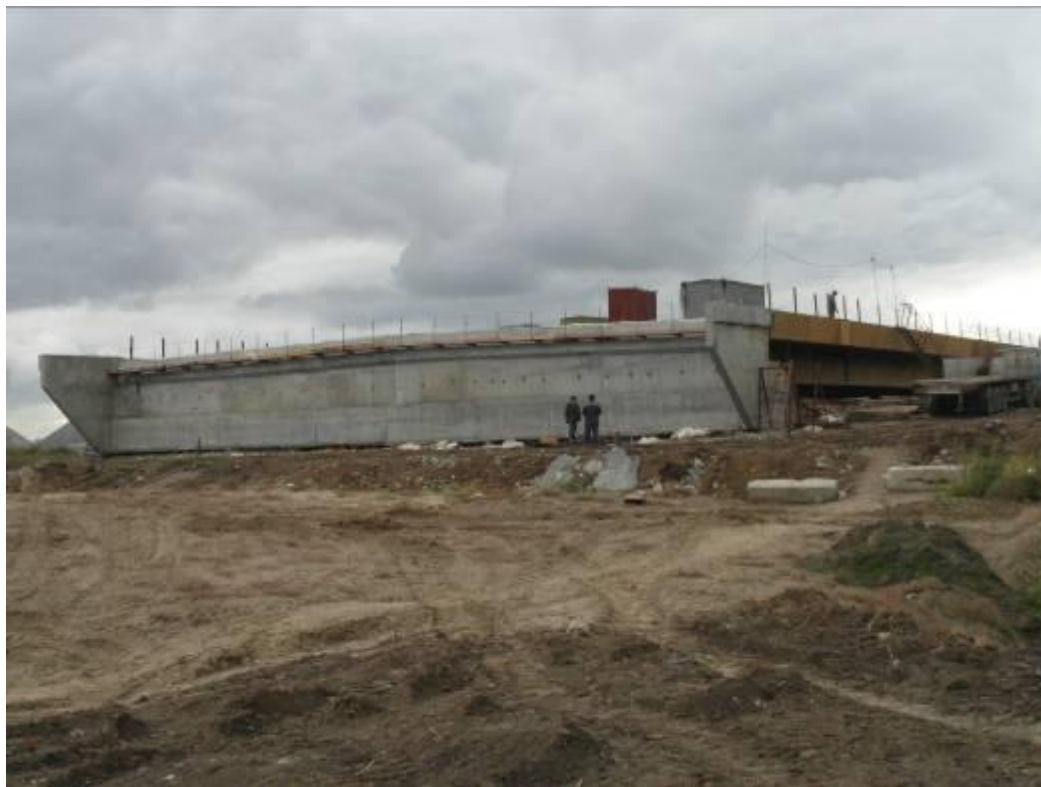
Эстакада будущего моста через Обь. 2012г.
