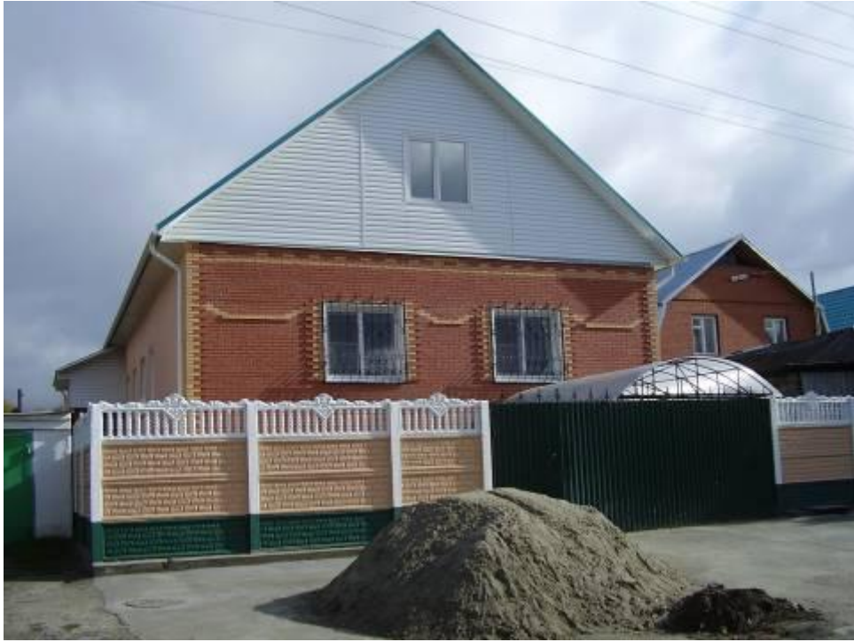
Ул. К. Либкнехта. Строящийся дом. 2008г.
