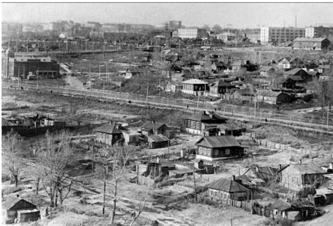
Ул. Большевистская от Коммунального моста.
