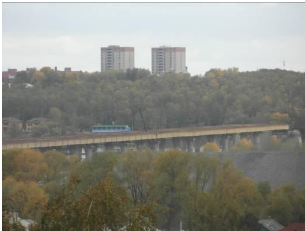
Вид с путепровода. Эстакада будущего моста через Обь. 2012г.
