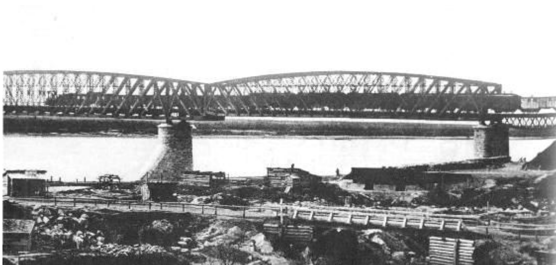
Железнодорожный мост. Начало будущей набережной.
