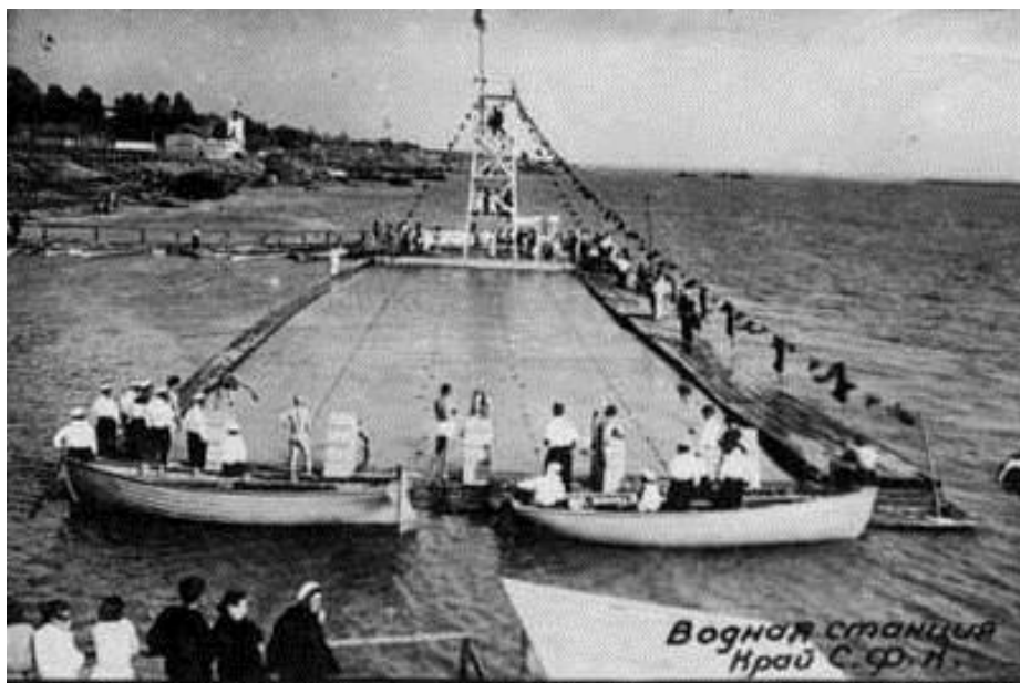
Бассейн с вышкой на вводной станции.
