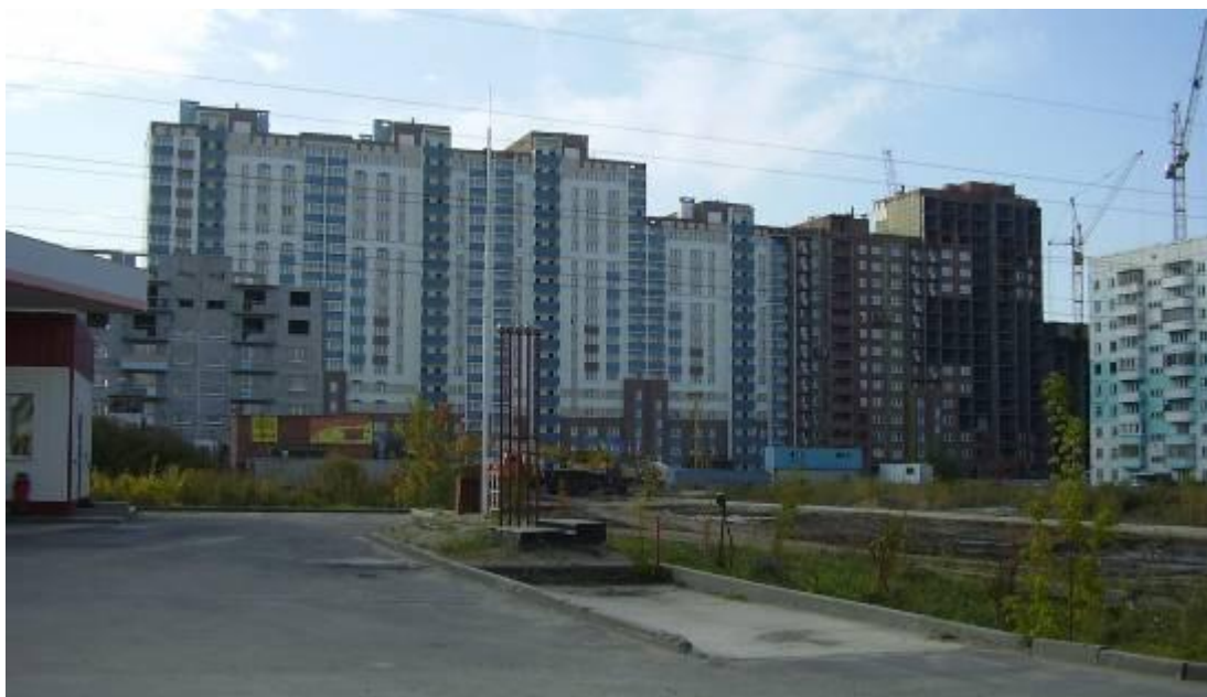
Ул. Выборная. Четная сторона. Жилой массив. 2008г.
