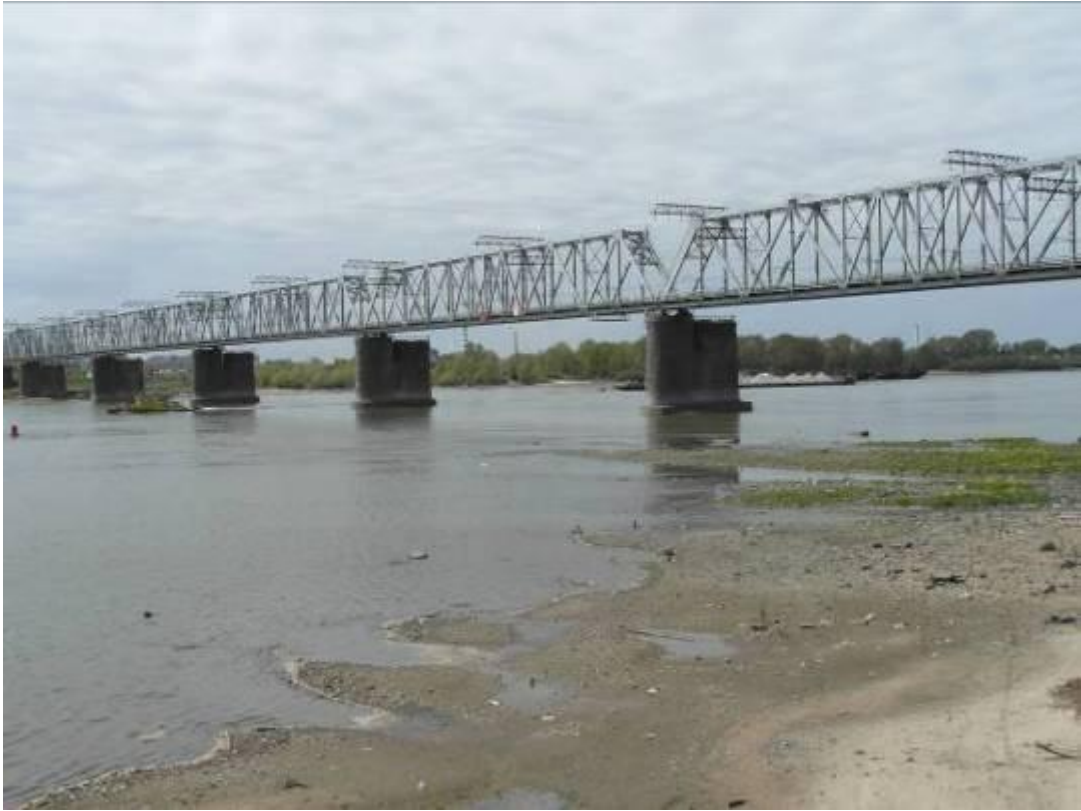
Новые фермы железнодорожного моста. 2012 г.
