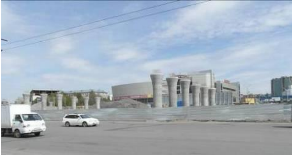
Строительство транспортной развязки на Южной площади. 2012г.
