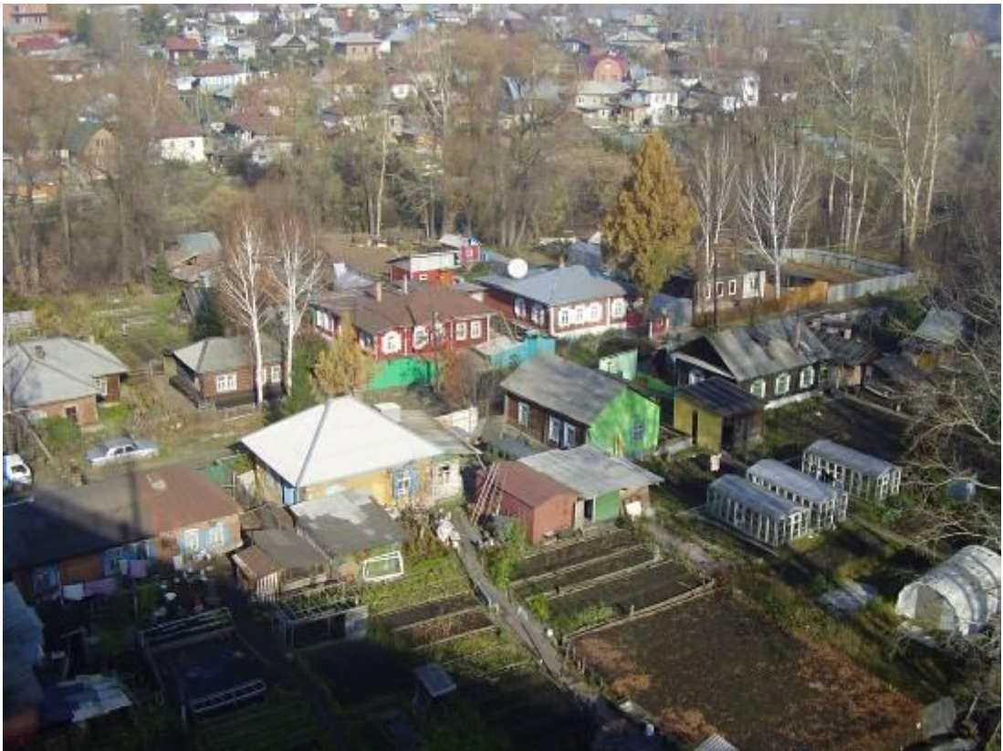
Застройка рядом с новой эстакадой. 2009г.
