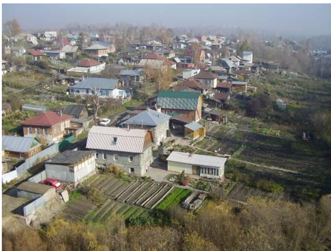
Застройка рядом с новой эстакадой. 2009г.
