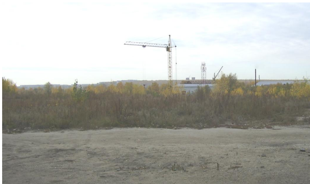
Ул. Большевистская. Краны на месте старого водозабора. 2008г.
