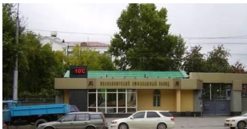
Ул. Кирова. Аффинажный завод. 2008г.
