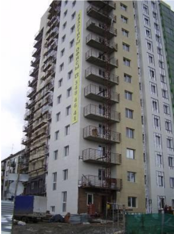
Ул. Добролюбова. Четная сторона. Строящийся дом. 2008г.
