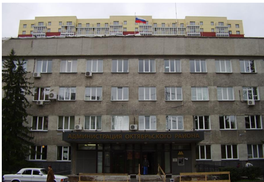
Здание Администрации Октябрьского района. 2008г.
