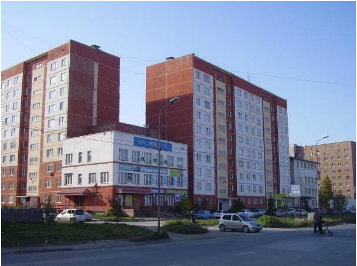
Ул. Выборная. Четная сторона. Жилой массив. 2008г.
