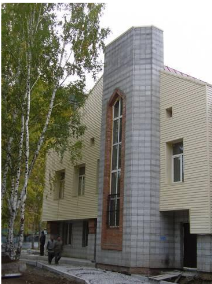
Ул. Добролюбова. Строящееся здание. 2008г.
