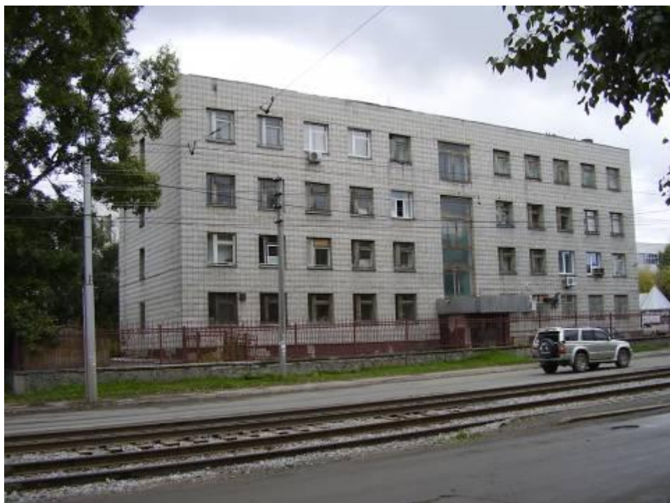
Ул. Гурьевская. Новая пристройка к Больнице. 2008г.
