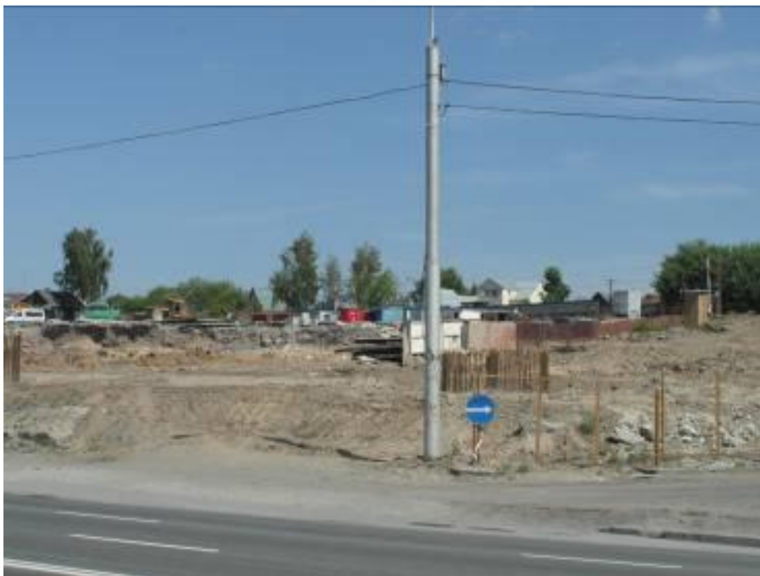
Ул. Большевистская. Сооружение транспортной развязки. 2012г.
