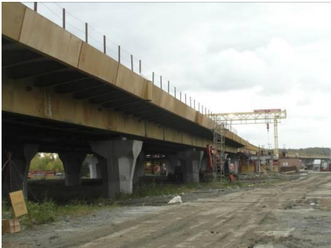
Эстакада будущего моста через Обь. 2012г.
