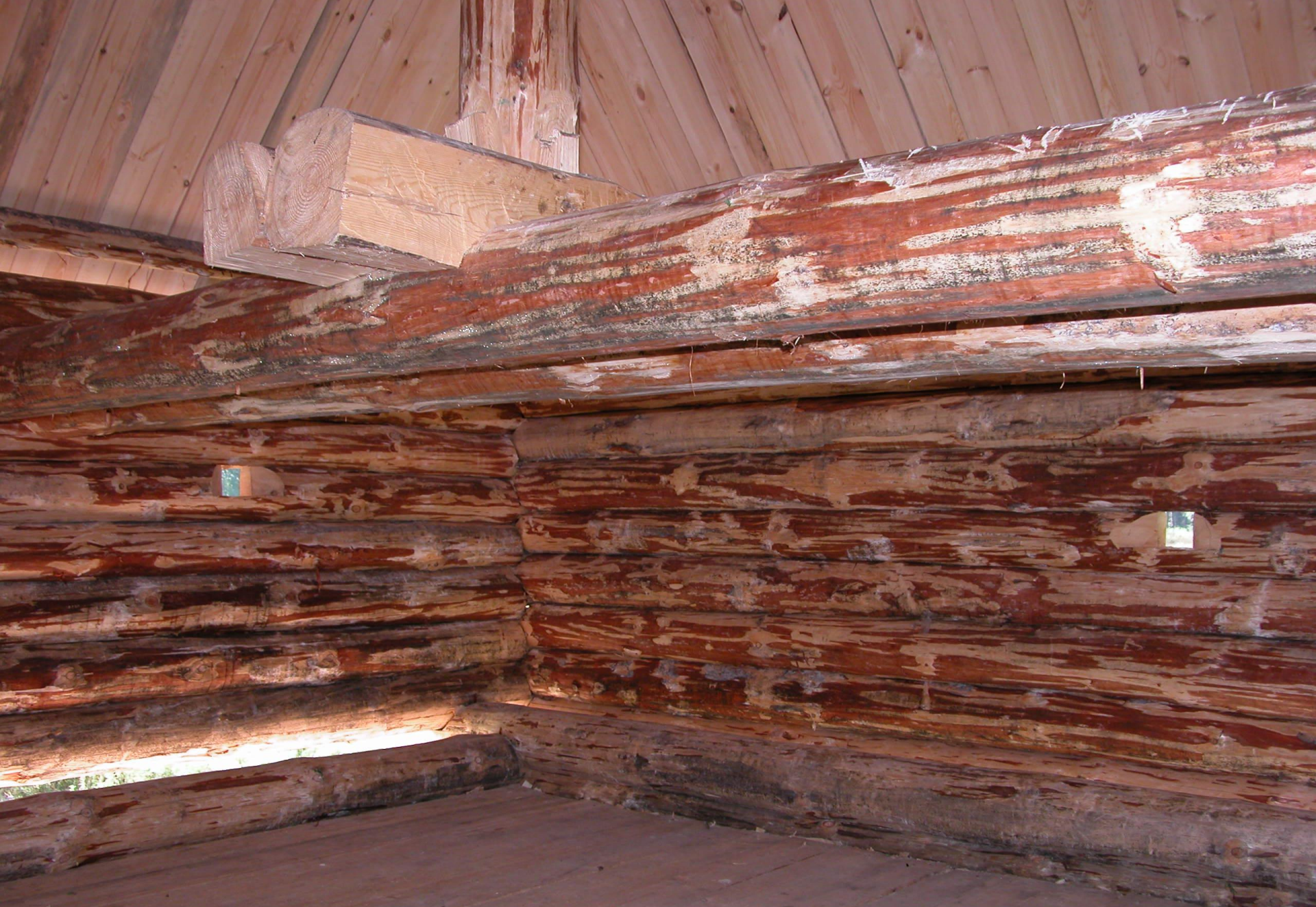
Внутреннее пространство верхнего помещения башни
