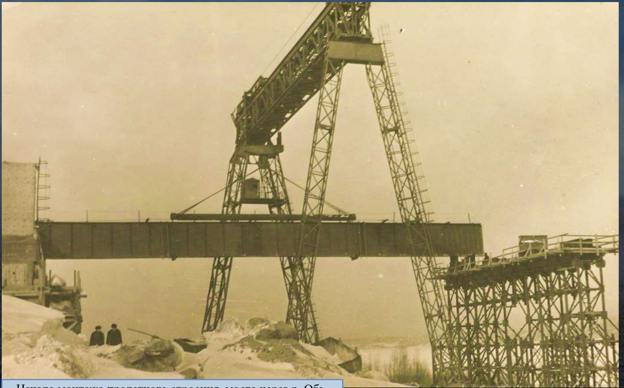
Начало монтажа пролетного строения моста через р. Обь. Надвижка на опоры железобетонных элементов пролетного строения, 1976 г.
