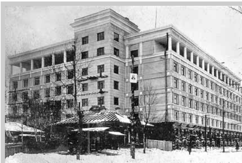
Ул. Урицкого, 37 — жилой дом Томской железной дороги был построен в 1935 году. На верхнем этаже здания были устроены обширные лоджии, которые немного позднее из-за несоответствия климатическим условиям были застроены и превращены в комнаты
