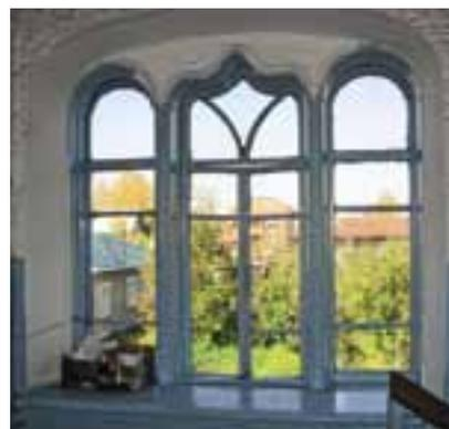
Окна первого этажа с лучковым завершением, акцентированы криволинейной клинчатой перемычкой. Центральные части восточного и южного фасадов выделены подобием портиков с двумя полуколонками, завершенными капителями с полукруглыми в плане абаками. Окна второго этажа с коробовой клинчатой перемычкой утоплены в нишах на плоскости фасада на полкирпича. Пространство между нишами в виде силуэтов колонн разделяет второй этаж здания по горизонтали.
