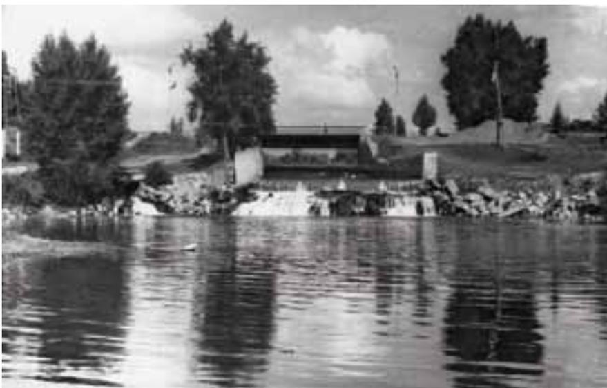
Вид на плотину. В центральной части плотины расположен «большой прорез», левее – «малый прорез». Фото 1981 года
