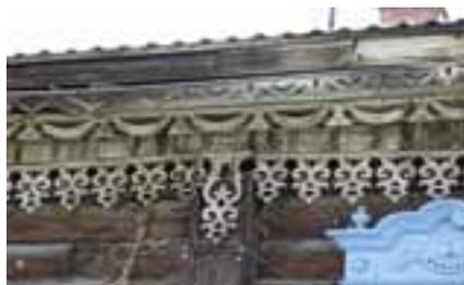
ложен накладной пропильный растительный декор. Фланкируют окно накладные полуколонки токарной работы. Переглеты окон деревянные. Карниз дома обшит досками. Подзор карниза состоит из двух рядов пропильной резьбы, построенной на сочетании геометрических и растительных мотивов. Свес карниза декорирован пропильным подзором, в котором также сочетаются геометрические городские мотивы – «сердечко» с растительным орнаментом.
