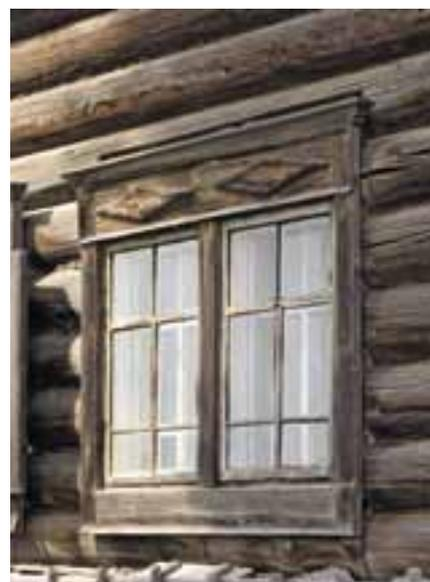
личники обрамляют высокие оконные проемы. В оформлении окон первого и второго этажа заметен контраст. Первый этаж декорирован наличниками более простой формы. Надоконная доска завершена профилированным карнизом, ее плоскость декорирована накладной
