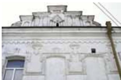
ским покрытием. Композиция фасадов асимметрична и насыщена декоративными элементами. Фасады декорированы лопатками, рустованными на первом этаже и филенчатыми на втором. Широкий междуэтажный пояс состоит из двух профилированных тяг с
