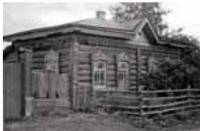
небольшой треугольный щипец, обшитый досками «в елочку», с небольшим круглым слуховым окном и пилястра, закрывающая место врубки поперечной внутренней стены. Углы дома декорированы пилястрами, которые состоят из вертикальных досок, обрамленных профилированными накладными элементами.
