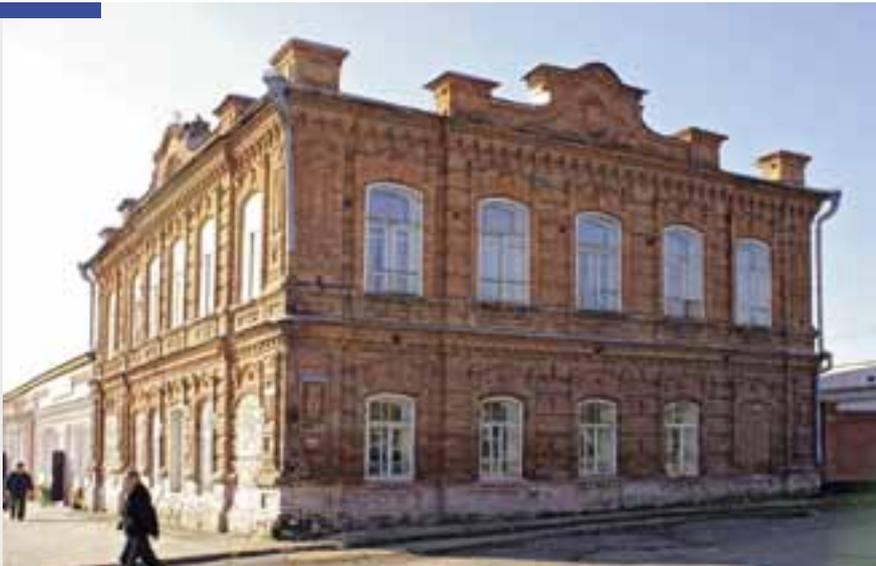
лопатками углов здания и мест пересечения внутренних несущих и внешних стен. Лопатки, завершённые криволинейными элементами, декорированы нишами и ширинками с накладными прямоугольными элементами со скругленными углами.
