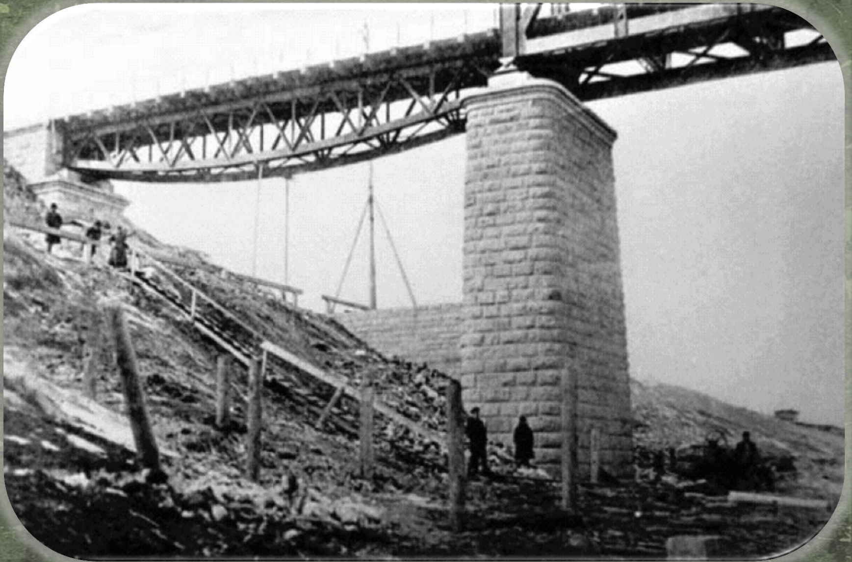
Строительство моста через Обь
