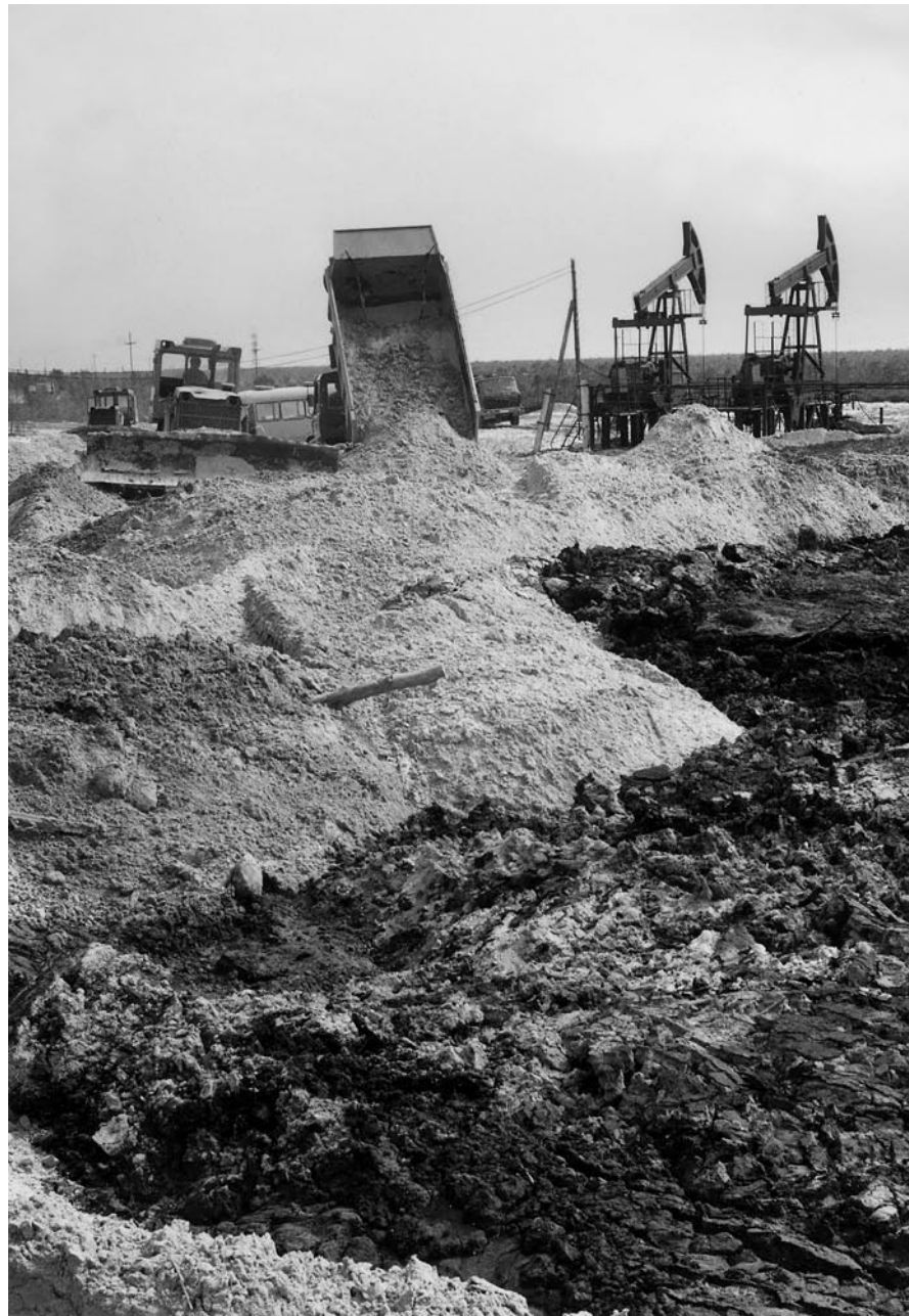
Рис. 44. Засыпка шламового амбара привозным песком.
