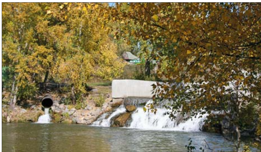
5. Вид на плотину (большой вешняный прорез). Постройка 1760-х гг. после реставрационно-ремонтных работ 2008 г.
