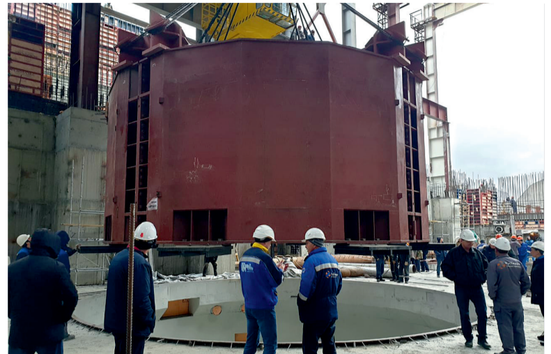
Одним из важных и ответственных моментов монтажа была процедура транспортировки статора гидрогенератора в шахту турбины
