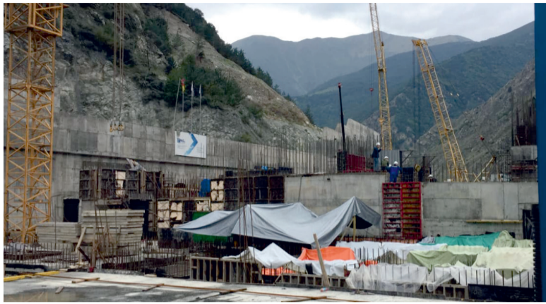
Фундамент будущей Зарамагской ГЭС-1
