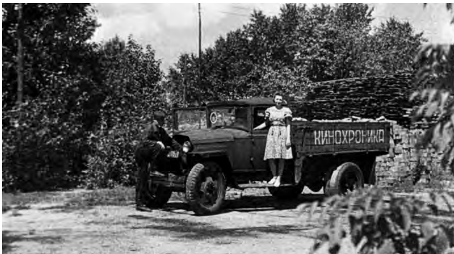
Внутренняя территория кинокопировальной фабрики (Музей Новосибирска)
