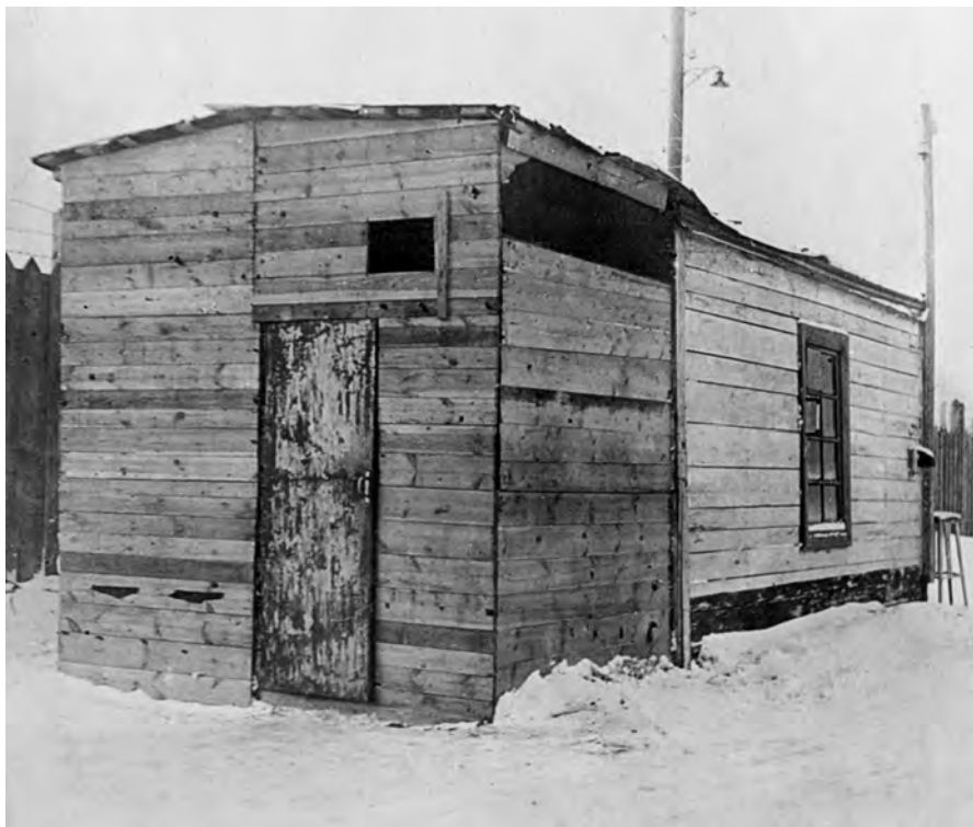
Здание первой ЛИС завода. 1936–39 годы (Музей Новосибирска)
