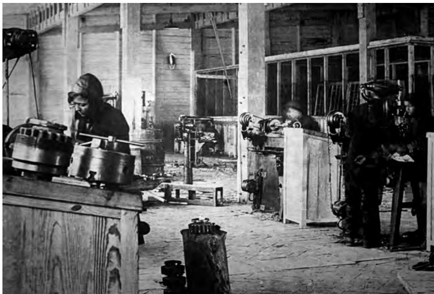
Монтаж вакуированного оборудования в механическом цехе завода № 153 4
