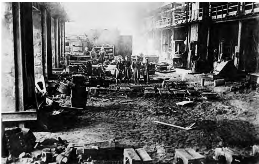
Участок чугунолитейного цеха завода им. Ефремова (Музей Новосибирска)
