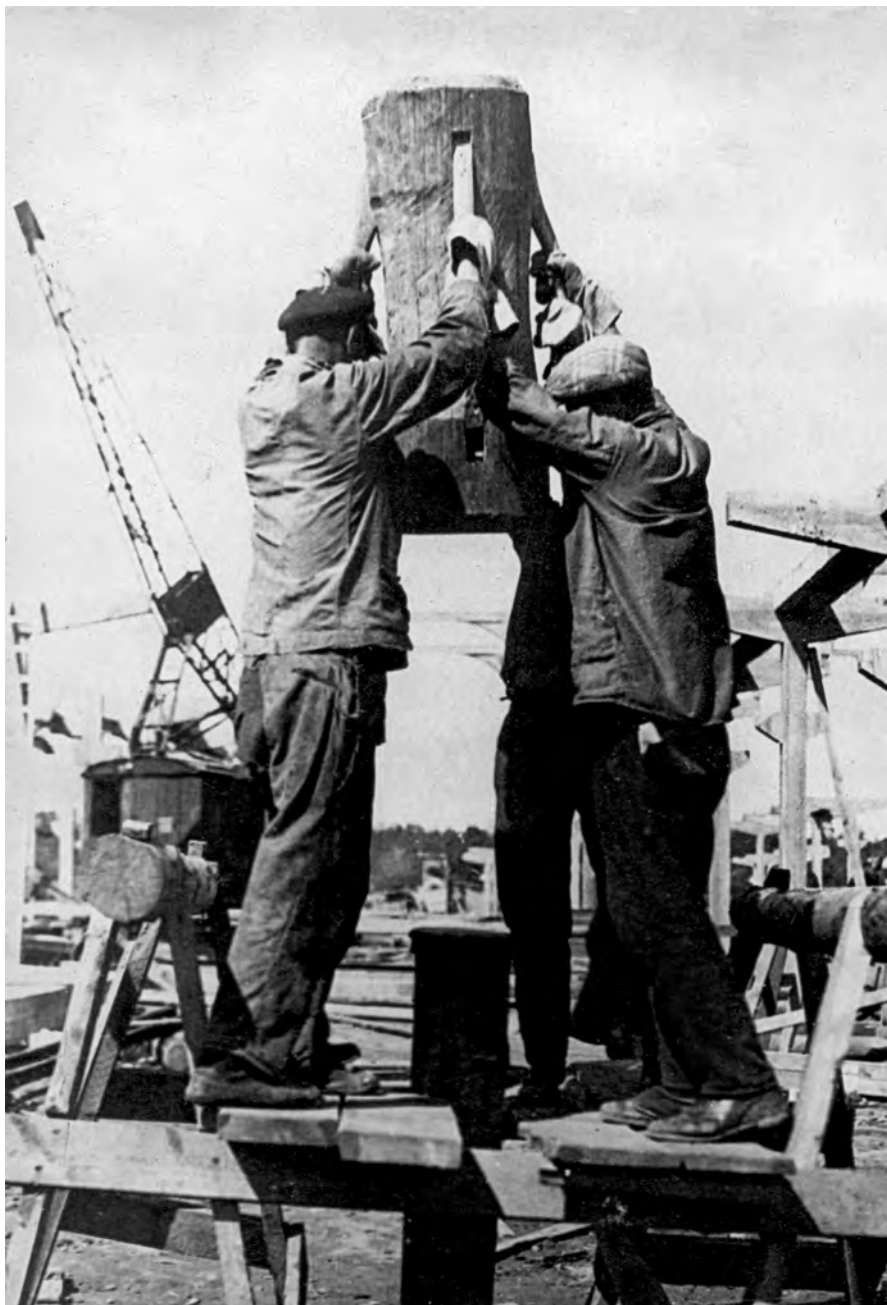
Забивка свай на строительстве главного корпуса завода № 644 (Музей Новосибирска)
