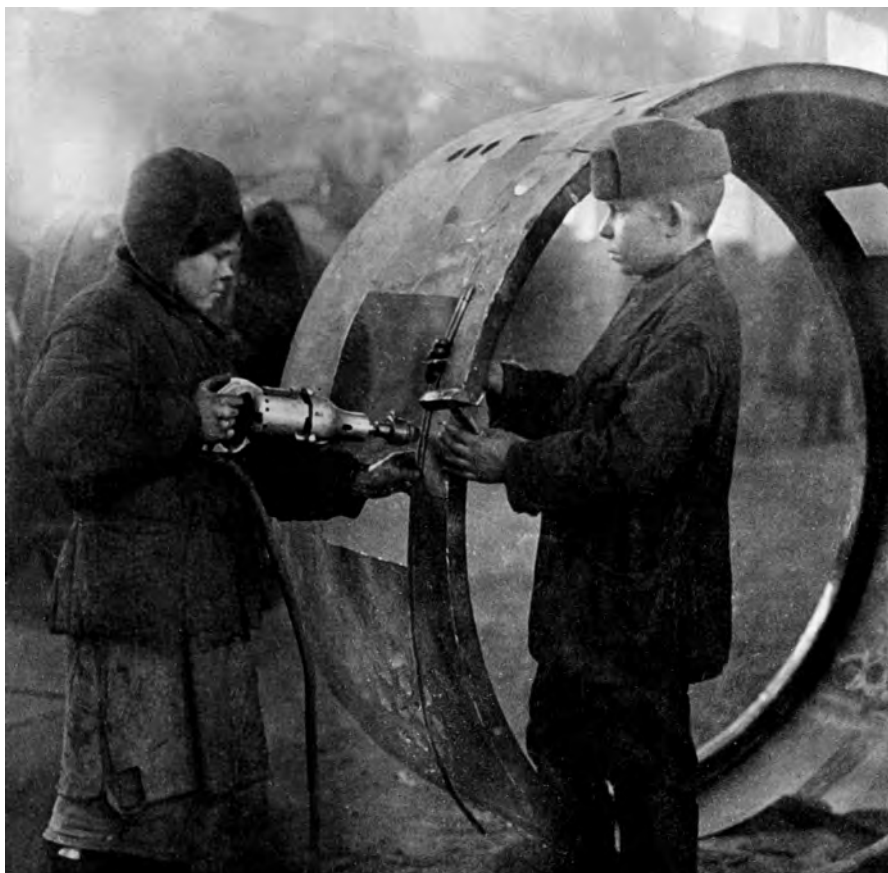
Рабочие присверливают обшивку к каркасу барабана прожектора З-15. Диаметр 1,65 метра. Слесарно-сварочный цех. 1943 год (Музей Новосибирска)
