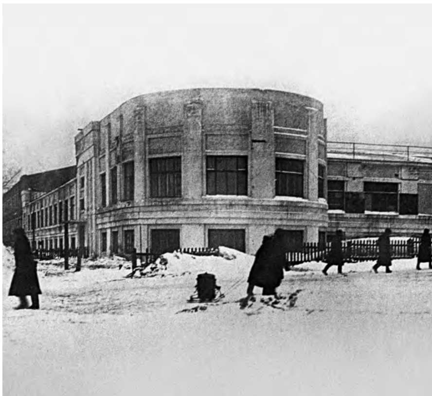
Заводоуправление завода «Электросигнал», Добролюбова, 31 (nsk-kraeved.ru)
