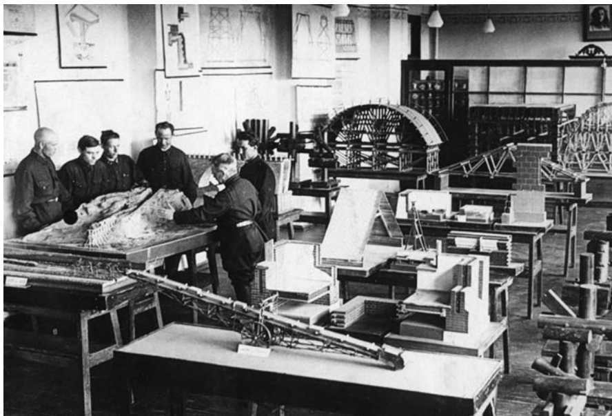
В кабинете строительного производства. НИВИТ 103
