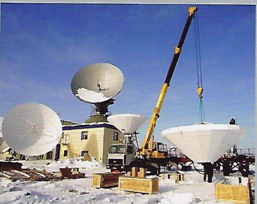
Монтаж антенн головной станции VSAT.
