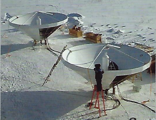
Монтаж облучателей антенн спутниковой связи.
