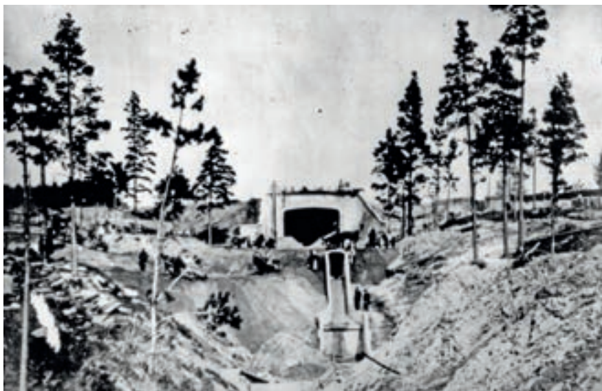
Строительство тоннеля, 1913 год
