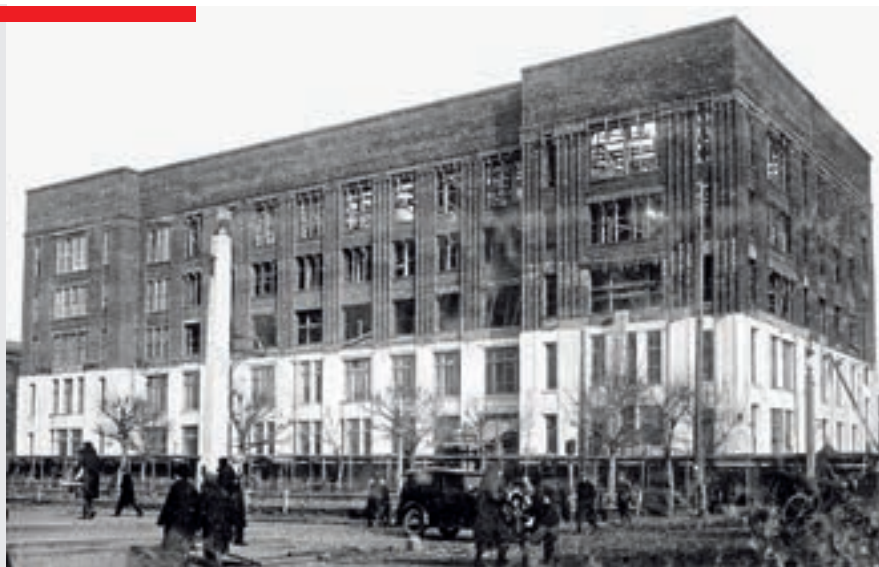
Реконструкция здания Госучреждений, 1935–1936 годы
