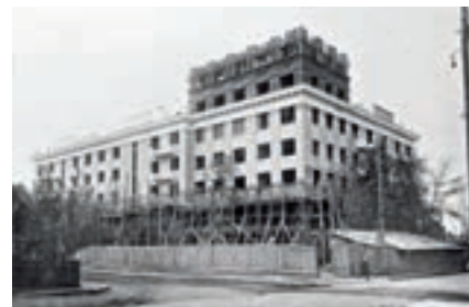
Строительство жилого дома, 1930-е годы
