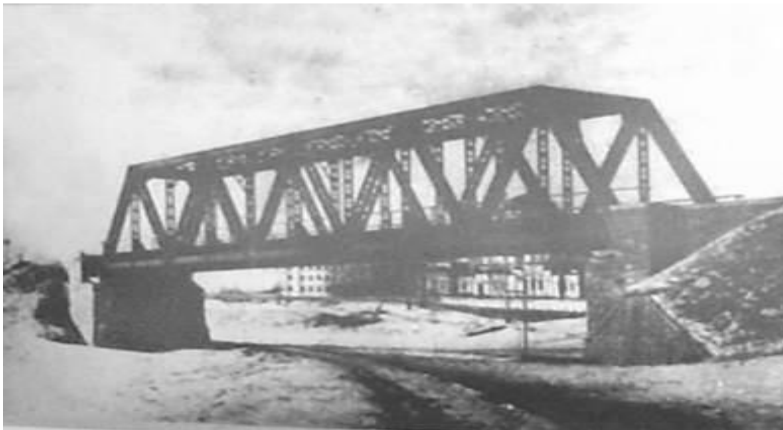
Алтайская железная дорога. Ферма над Транссибом.
