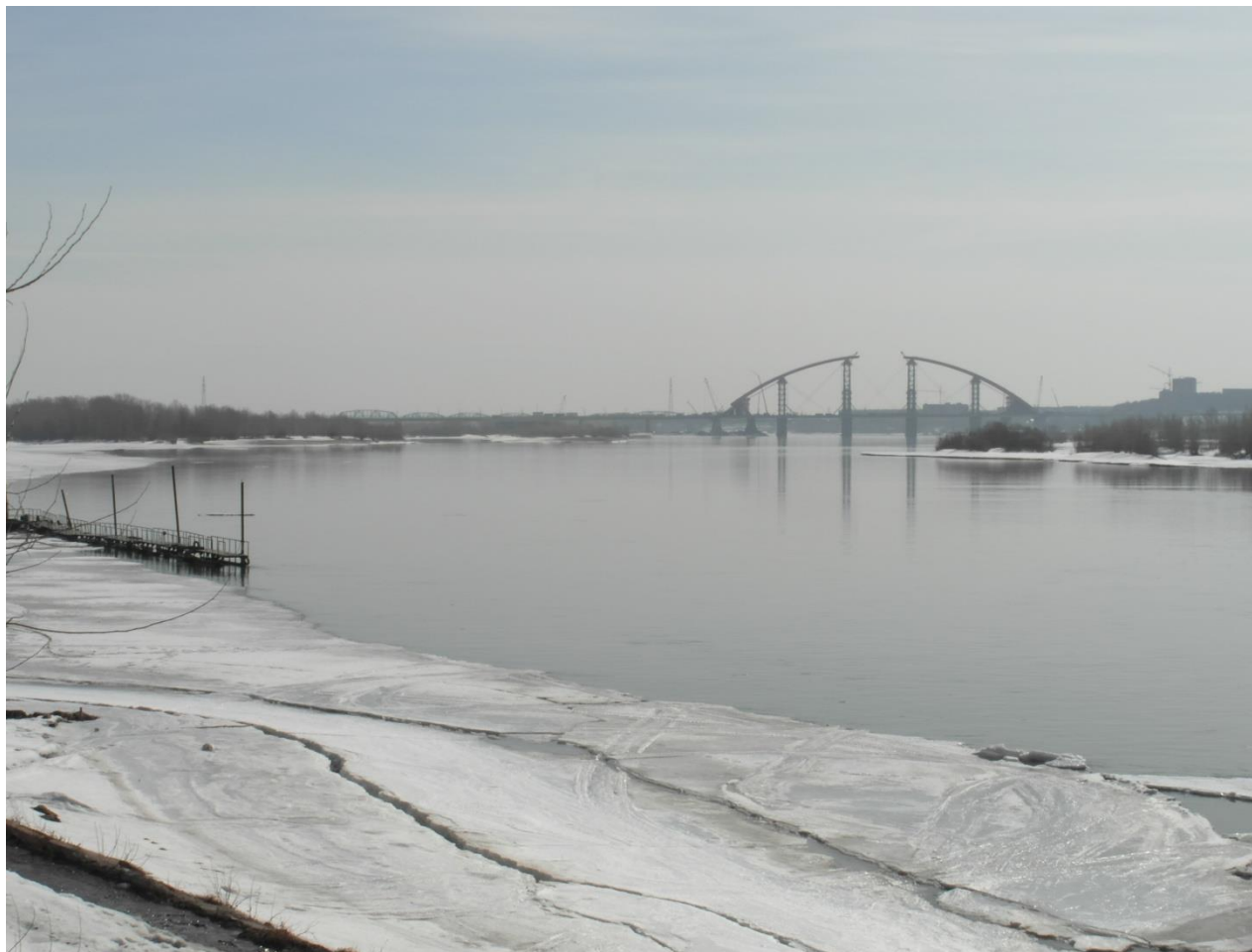
Вид с набережной на будущий Бугринский мост. 22.03.2014г. 016
