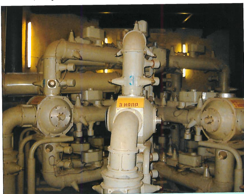
Антенный коммутатор КВ-передатчиков, РЦ-9
