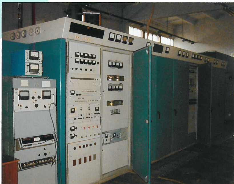
Современный РВ-передатчик «Прибой» ДВ-диапазона, РС-9
