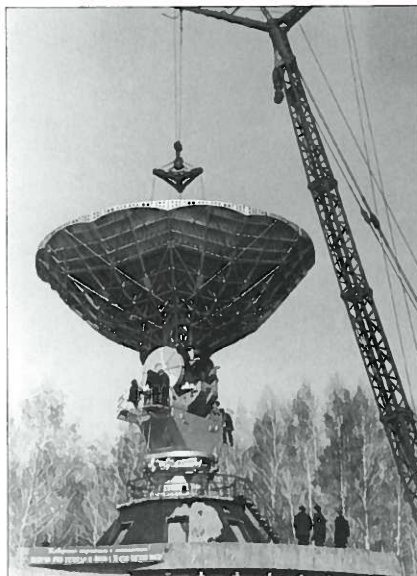
Завершение монтажа оборудования на ЗССС «Орбита»
