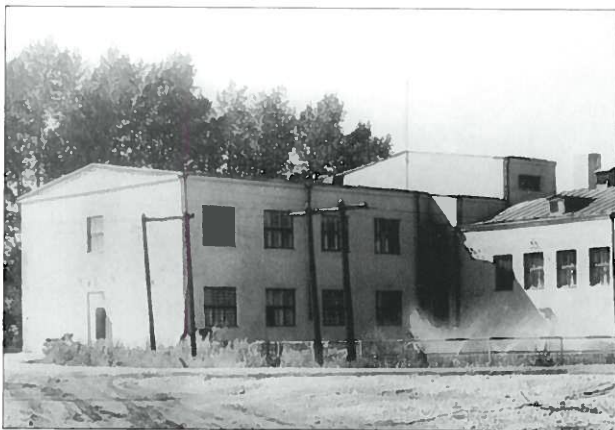
Техническое здание коротковолнового цеха
