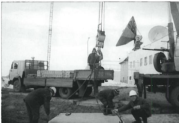
Подготовительные работы к установке антенны
