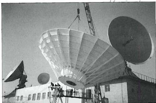
Установка зеркала НАС-9,3 на опорно-поворотное устройство
