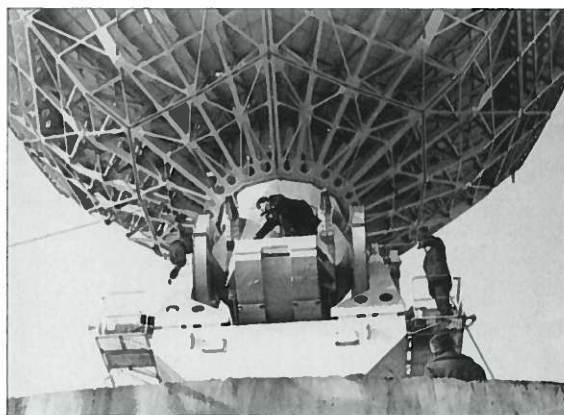
Настройка параболической антенны на ЗССС «Орбита»
