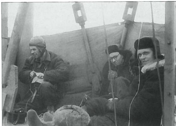
Ремонтная бригада устраняет заводской брак антенны, июнь 1960 г.
