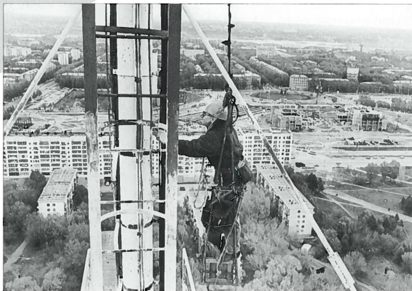
Монтажные работы на новосибирской телевизионной мачте
