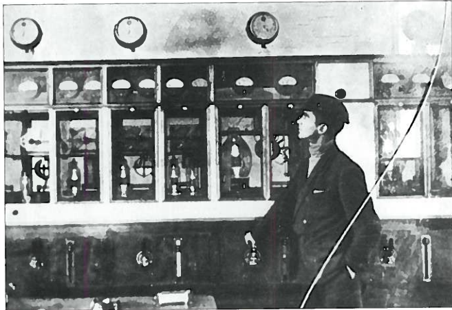
Генераторный зал КВЦ, 1935 г. За работой сменный радиотехник Г. М. Кобзарь
