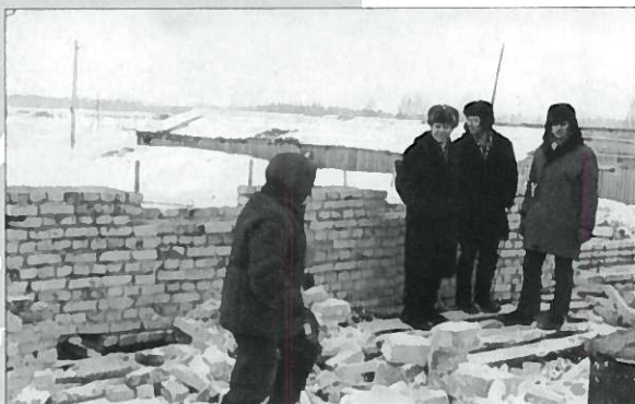
Начальник РС-9 П. Е. Маслов (крайний слева) проверяет ход возведения корпуса ТЗ-3
