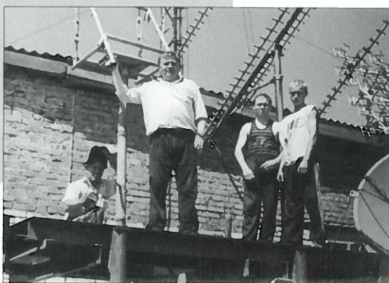
Н. С. Филоненко на монтаже антенного оборудования в РТПС г. Куйбышева
