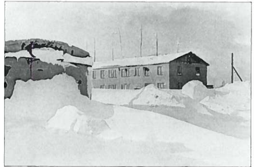
Временное жилое сооружение для строителей РС-9
