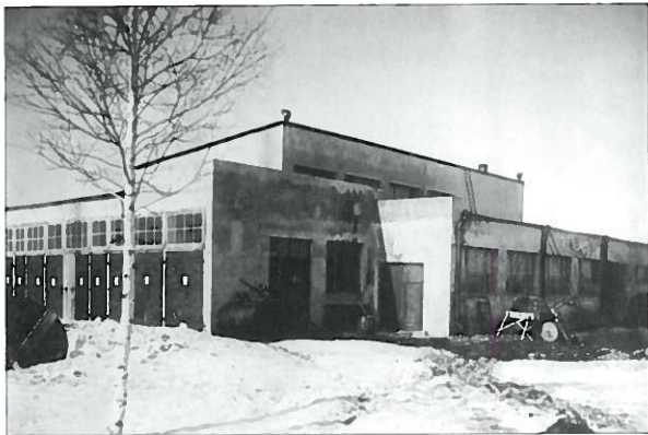
Техническое здание РВ-76, 1932 г.
