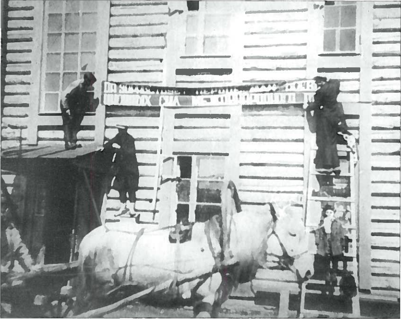
Жилой дом для сотрудников станции, 1935 г.
