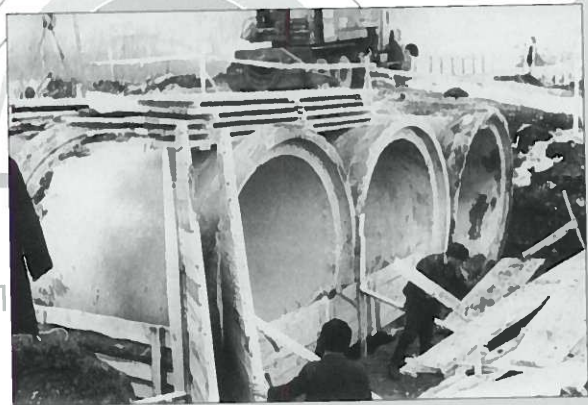
Строительство автомобильной дороги от п. Радуга к п. Ояш
