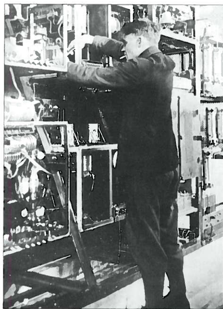
Монтаж передатчика ведет В. В. Казаков, 1935 г.
