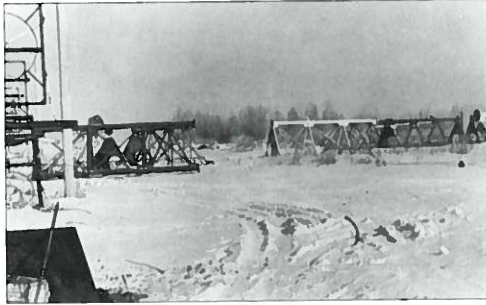
Начало монтажа антенны «АРРТ» на Радиостанции № 9 1967 г.
