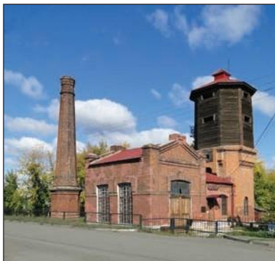
Комплекс сооружений насосной станции
